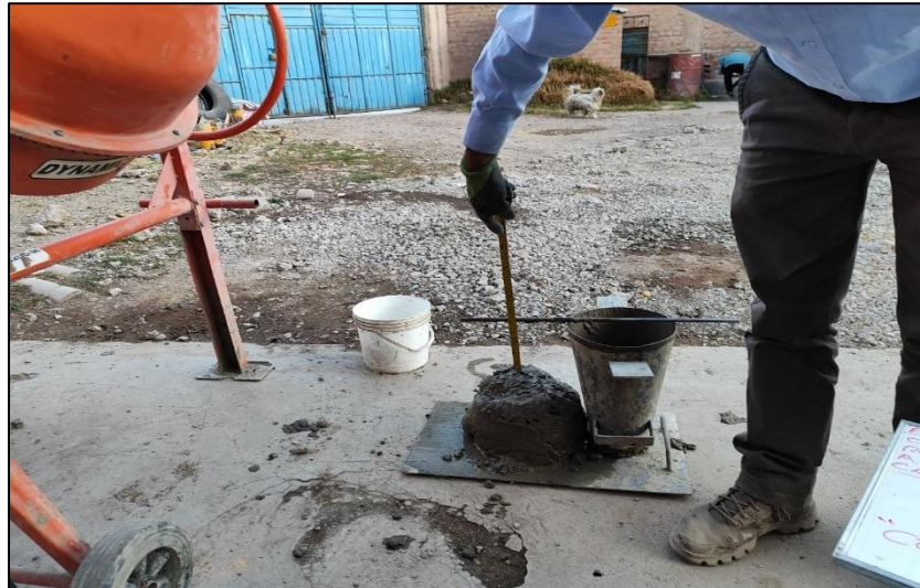
Fotografía 11. Medición del asentamiento del concreto.
