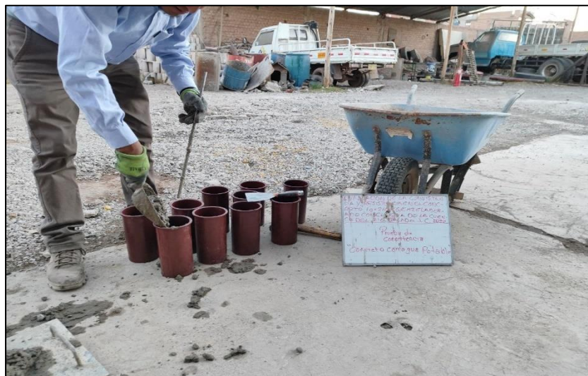
Fotografía 12. Vaciado del concreto en los moldes.
