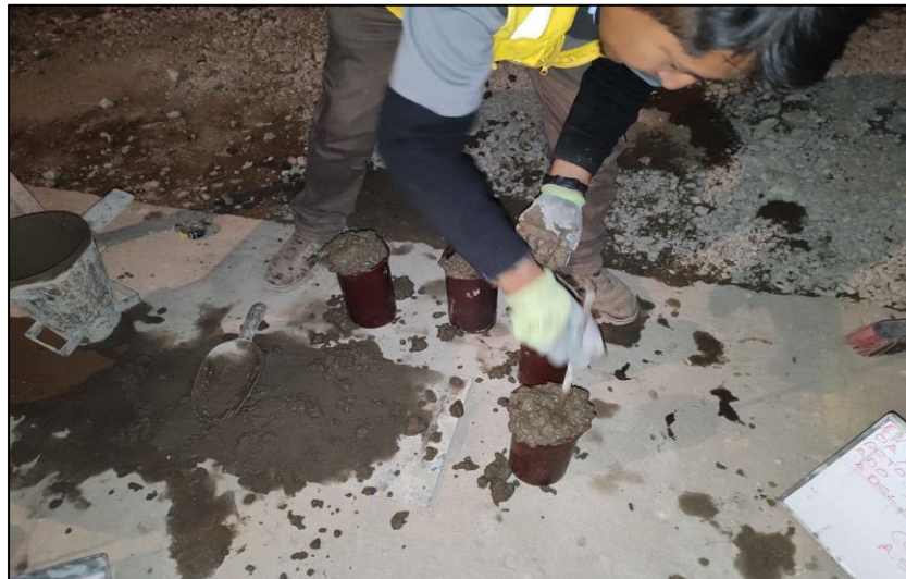
Fotografía 14. Chuseado del concreto.
