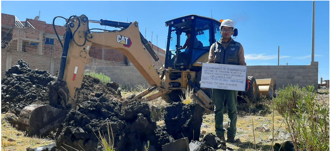
EXCAVACIONES REALIZADAS PARA LA EXTRACCIÓN DE MUESTRAS
