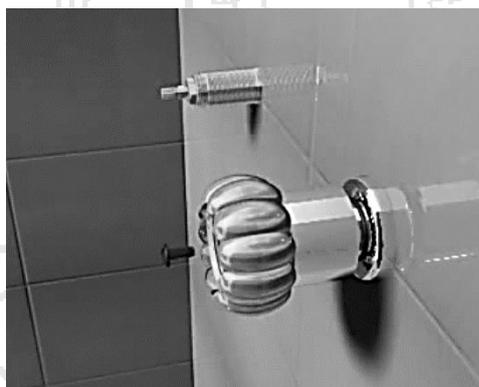
*DETALLE N° 102. Instalación de llaves en mescladora.*
