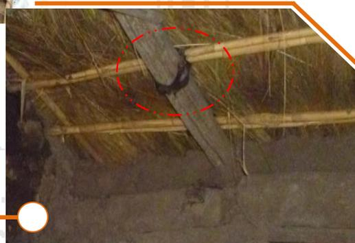
Ya con la cantidad necesaria de paja, palos y los lazos se procede a hacer la estructura del techo, ya sea en bóveda, a dos aguas o cuatro aguas, los palos son amarrados con el lazo en cada unión; de tal manera que se pueda fijar y estabilizar el techo. Posterior a esto se procede con el colocado de la paja para formar el techo. En esta actividad existen dos formas de techado o técnicas:
