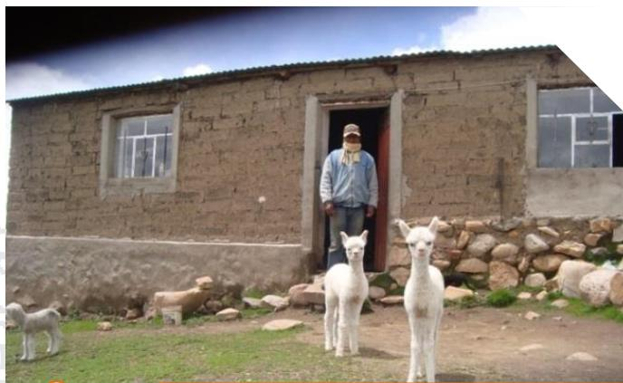
**IMAGEN N° 113.** uso del cemento en tarrajeo de zócalos.
