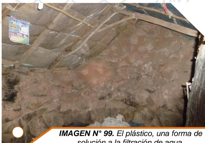
**IMAGEN N° 99.** El plástico, una forma de solución a la filtración de agua.
