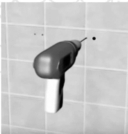
**DETALLE N° 94.** Perforado de orificios para asegurado de urinario.
