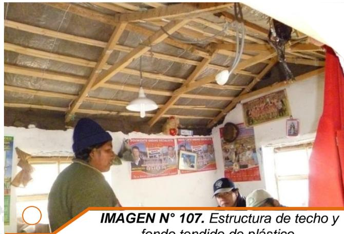
**IMAGEN N° 107.** Estructura de techo y fondo tendido de plástico.
