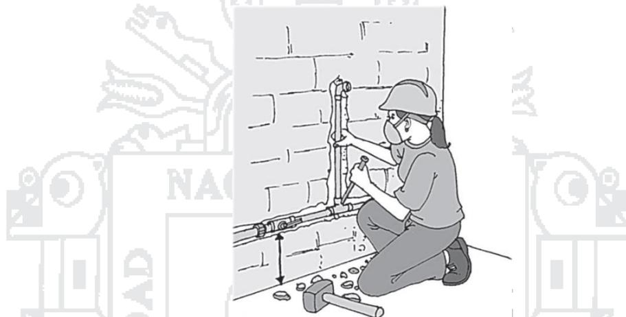
**IMAGEN N° 276.** Instalación de tubería de agua en pared.
