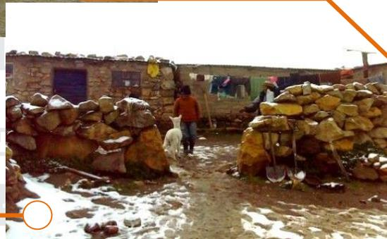
⊕ **MUROS:** según la visita de campo observamos que se han combinado los materiales como la piedra y el adobe, y a su vez los procesos constructivos, cimentaciones de piedra y mortero con y muro de piedra a media altura. Luego se termina el muro con adobe con un espesor de 0.30cm; la altura promedio de los muros generalmente está entre los 1.80m hasta los 2.40m.
