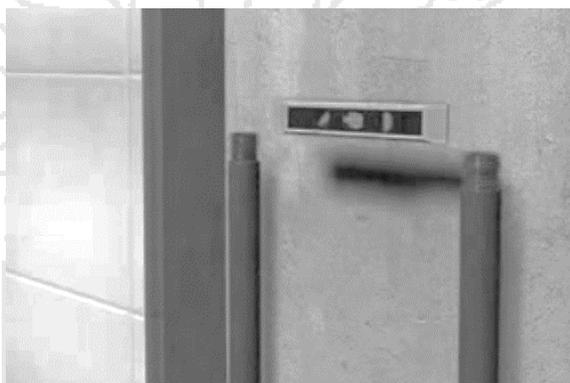
**DETALLE N° 99.** Nivelado de tubería para mezcladora de agua.
