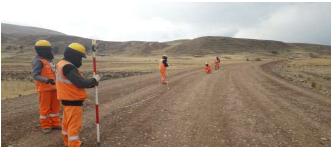
Figura 30. Topografía: Control, planimétrico para conformación de la sub base granular
