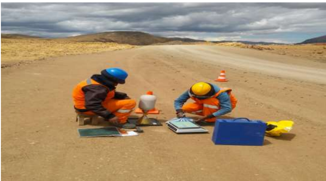
Figura 32. Pruebas de control de calidad: ensayo de densidad de campo
