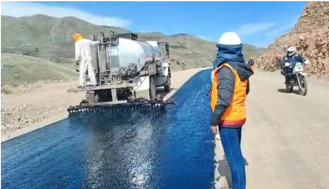
Figura 31. Pavimentos: imprimación
