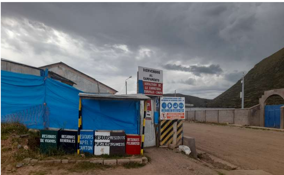
Figura 26. Campamento de la obra
