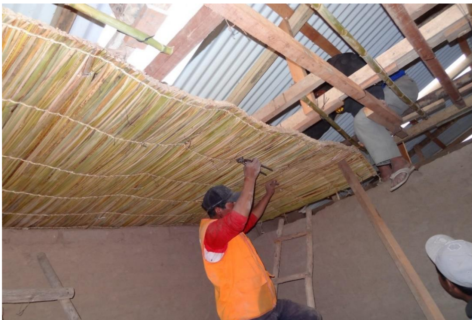
Figura 15. Colocado de la k'esana al cielo raso dentro de la HAT
