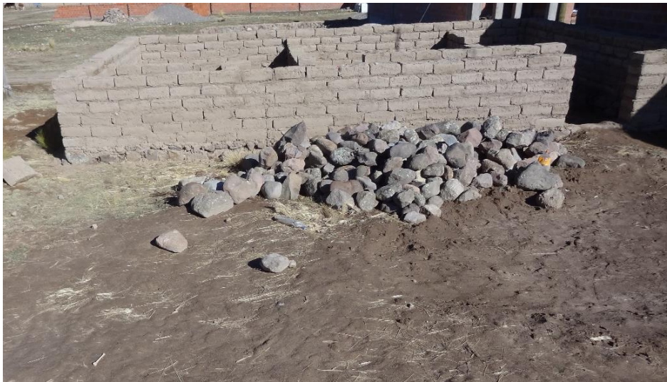
Figura 12. Inicio de la construcción de la HAT
