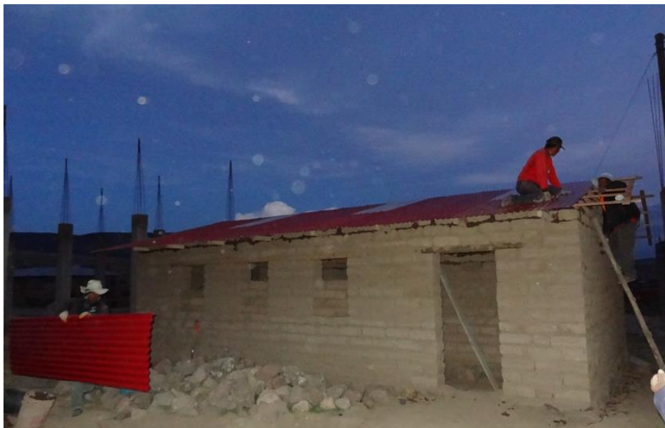
Figura 13. En esta imagen se aprecia el techado de la HAT
