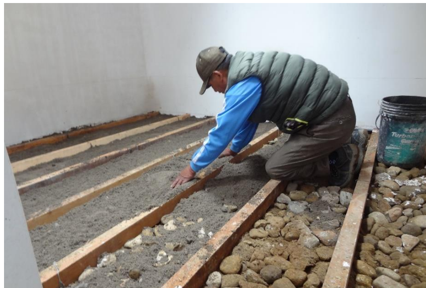
Figura 7. El piso es colocado con materiales de baja conductividad
