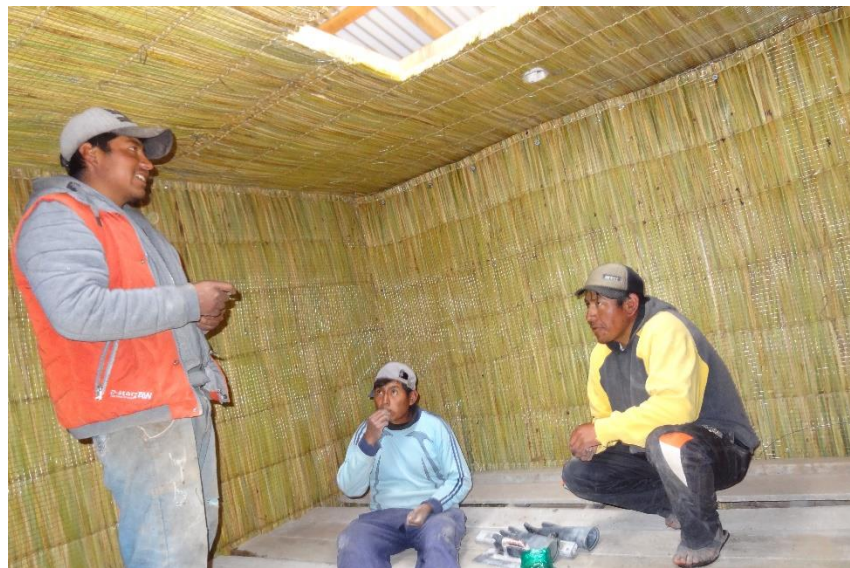
Figura 6. Aislamiento de muros
