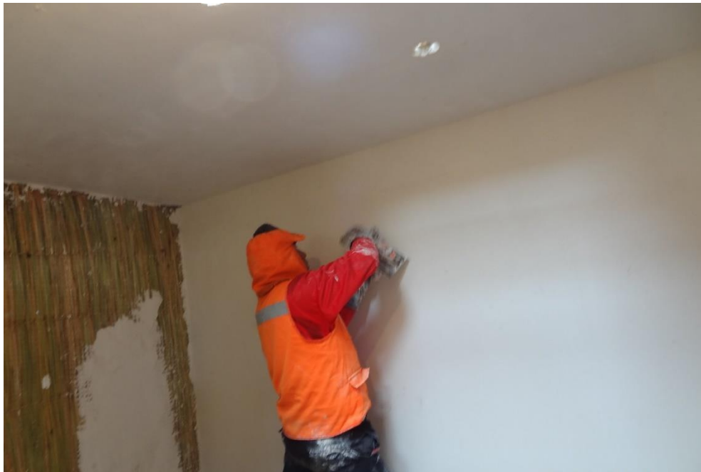
Figura 16. Enlucido del cielo raso y las paredes con yeso dentro de la HAT
