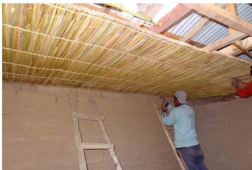
Figura 5. Aislamiento del cielo raso
