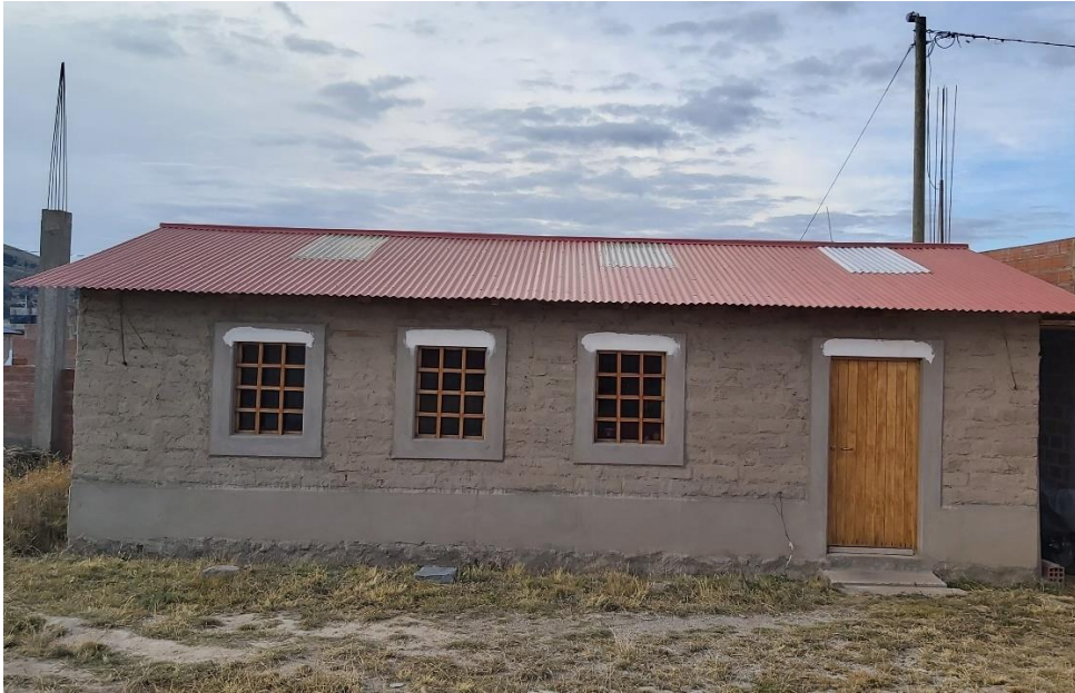
Figura 18. La imagen muestra la habitación térmica construida, lista para monitoreo de datos
