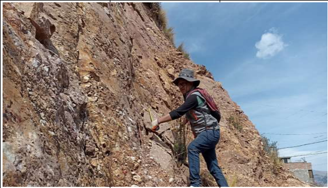
Fotografía N°7. Midiendo la persistencia, continuidad, meteorización, rugosidad, condición hidrológica del macizo rocoso.
