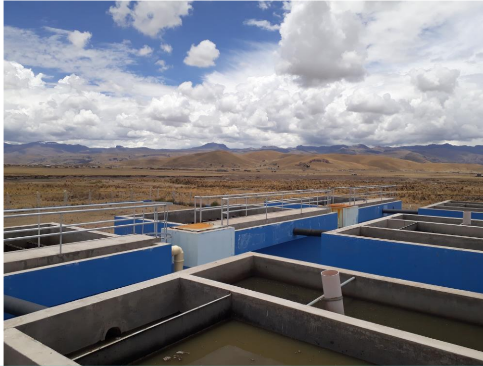
VISTA 03: Vista de planta del tanque Imhoff
