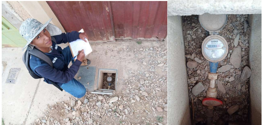
Fotografía 08. Registro de datos del 22 de enero de 2023 obtenido del micromedidor de la conexión domiciliaria con código 6975 – lectura 844.874
