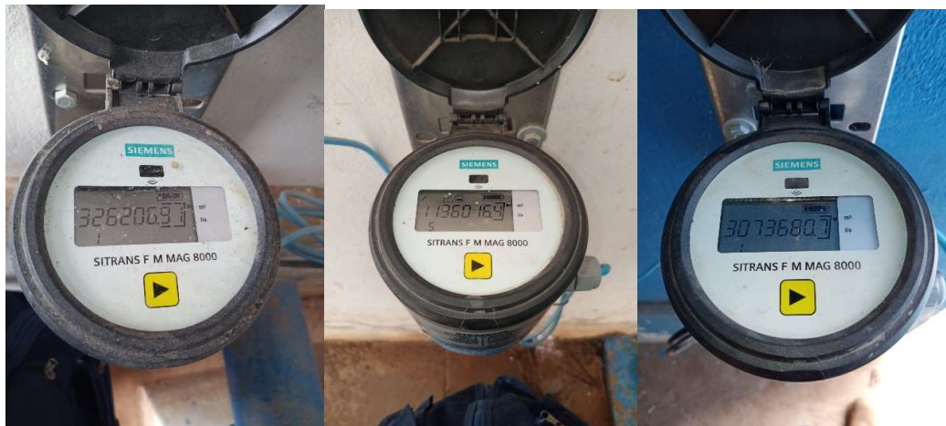
Fotografía 11. Registro de datos del 31 de diciembre de 2022 obtenidos de los macromedidores 05, 03, 01 respectivamente.
