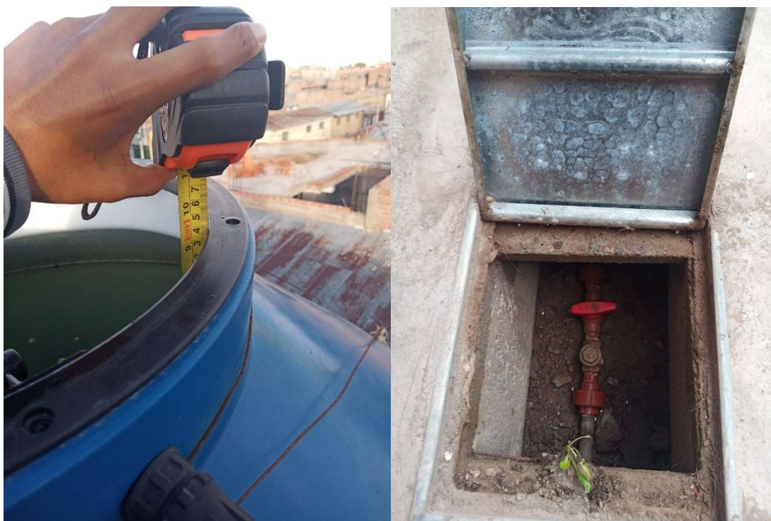
Fotografía 06. Medición del nivel de agua en el tanque elevado lleno y cierre de la válvula de ingreso.
