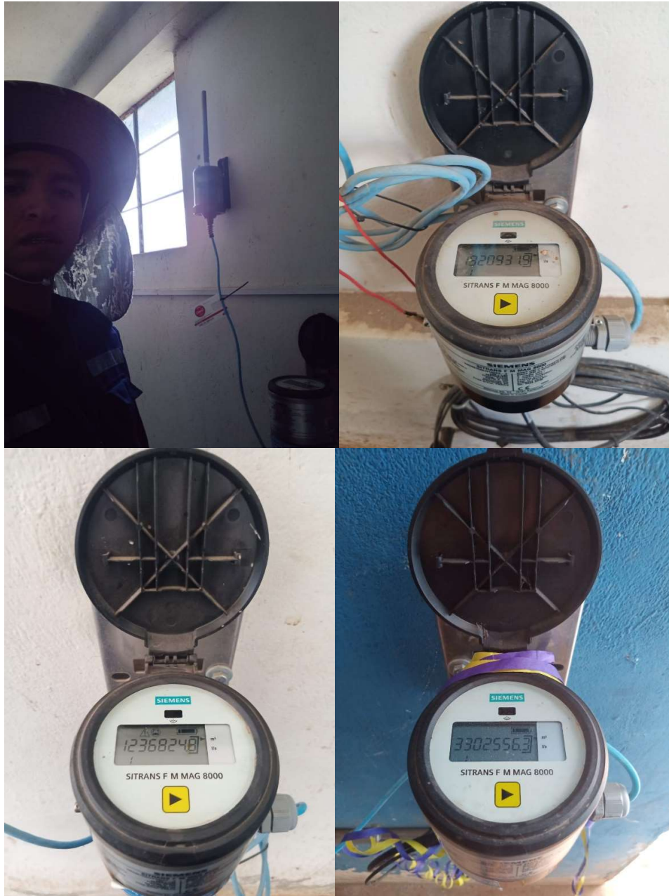
Fotografía 06. Registro de datos del 28 de febrero de 2023 obtenidos de los macromedidores 02, 03 y 01 respectivamente
