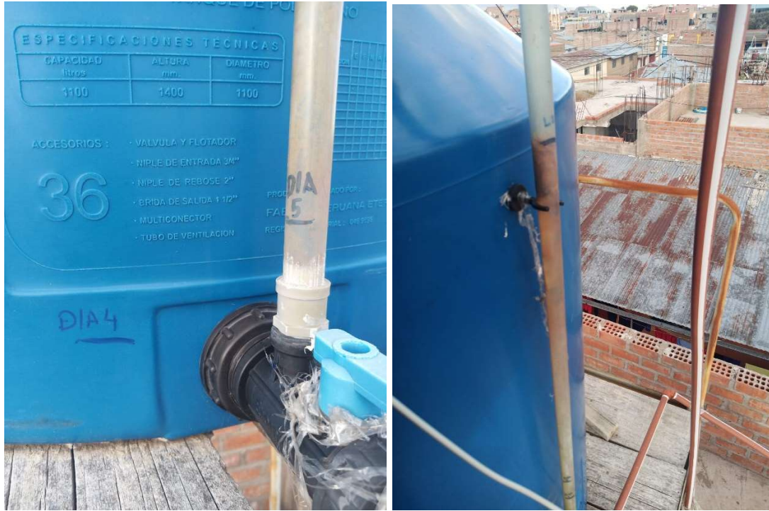
Fotografía 07. Medición del nivel de agua en el tanque elevado
