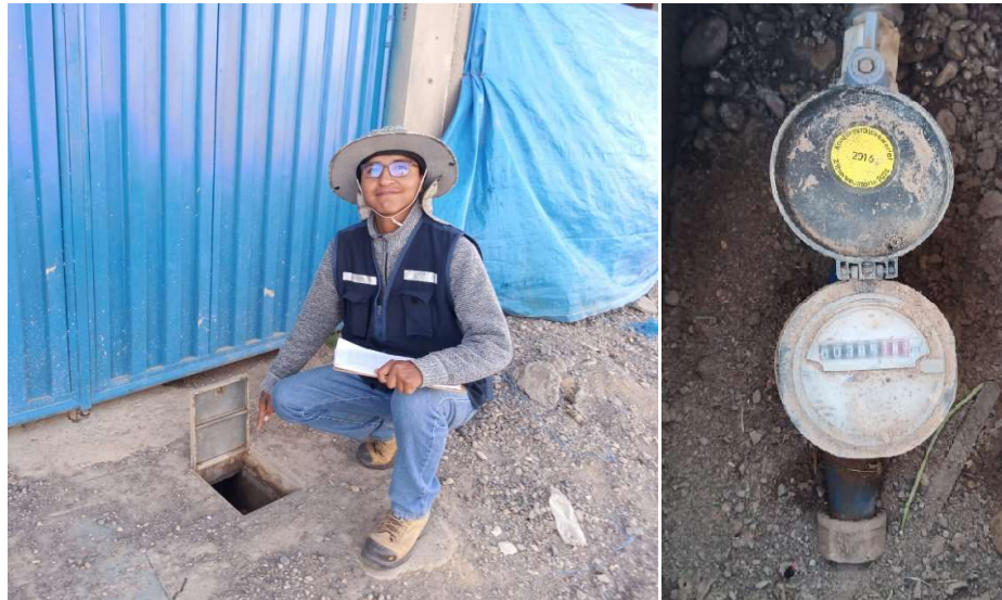
Fotografía 08. Registro de datos del 14 de enero de 2023 obtenido del micromedidor de la conexión domiciliaria con código 7124 – lectura 385.383
