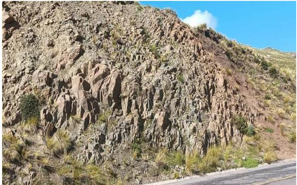
En la figura 31 exhibe la fracturación de la roca, pero evidenciando una menor alteración en comparación con el talud anterior, el cual se da con el valor más alto de RQD y RMR con el anterior talud, esta se encuentra en la progresiva Km. 233+050.
