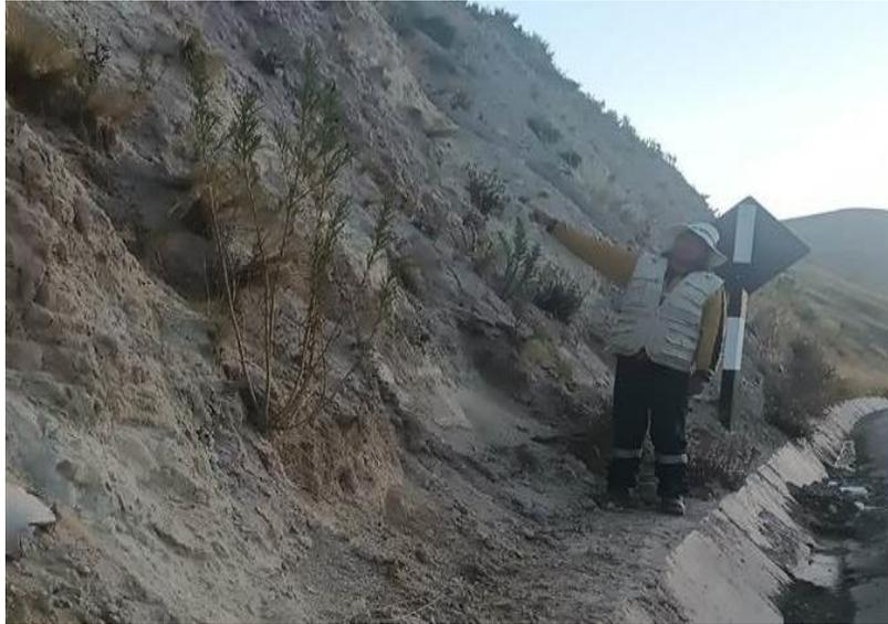
**Fotografía 01.** Identificación de la zona de caída de material hacia la cuneta, en la progresiva Km. 233+480.
