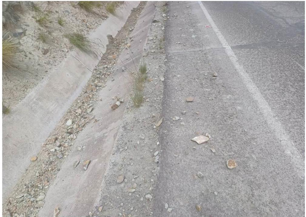
La figura 36 ilustra el impacto de la caída del material, que interrumpe el flujo de agua y causa daños en la cuneta de evacuación, se encuentra en la progresiva Km. 233+600.
