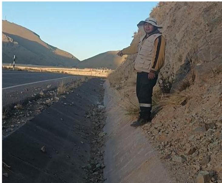
**Fotografía 02.** Vista de caída de pequeños bloques de roca hacia la cuneta y la vía, en la progresiva Km. 233+540.
