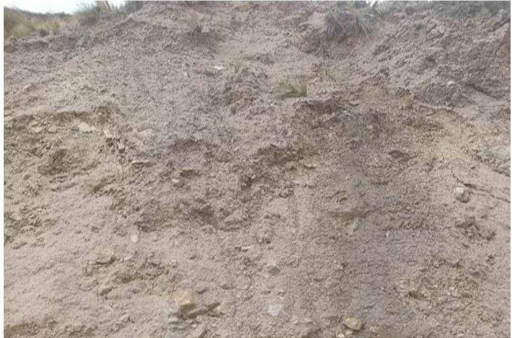
La figura 34 ilustra el nivel de erosión del talud, lo que conlleva a una situación de inestabilidad, esta se encuentra en la progresiva Km. 233+300.
