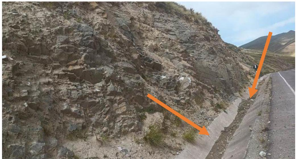
La figura 29 muestra la presencia de bloques de tamaño reducido, menores a 0.10 m, los cuales interrumpen el flujo de agua en la cuneta diseñada para la evacuación de aguas superficiales, esta se encuentra en la progresiva Km. 233+540 La causa principal de esta obstrucción se atribuye a la fracturación y erosión del material, agravada por la inclinación del talud, lo que propicia una erosión más rápida.
