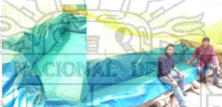
Figura 4. 27 Muestra la poza de curación del concreto permeable
