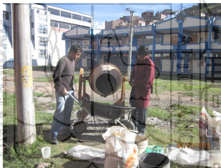
Figura 4. 17 Muestra el mezclado del concreto permeable
