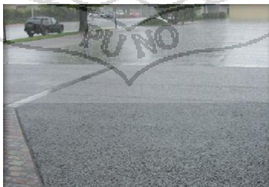
Figura 2. 3 Influencia de la precipitación en el pavimento permeable. ( www.imcyc.com/revistacyt/jun11/arttecnologia.htm ) (Fecha de actualización: 01 de Julio de 2015).
