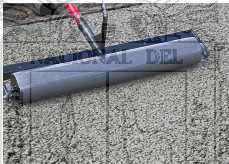
Figura 2. 26 Rodillo pequeño usado para compactar un área pavimentada pequeña ( http://www.perviousconcrete.com/images/build07/cert_pervious_roller.gif ). (Fecha de actualización: 08 de Julio de 2015).
