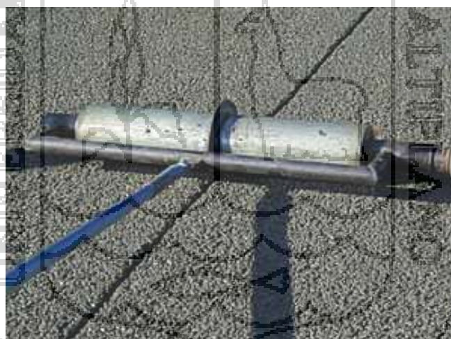
Figura 2. 27 Construcción de una junta mediante la adaptación de una hoja en el rodillo de compactación ( http://www.ctre.iastate.edu/Research/project_photos/pervious_joint.jpg ). (Fecha de actualización: 08 de Julio de 2015).
