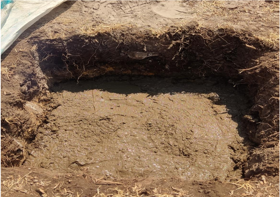
Nota: La fotografía representa la mezcla del concreto de la segunda capa para el punto PCG02. Elaboración propia.
