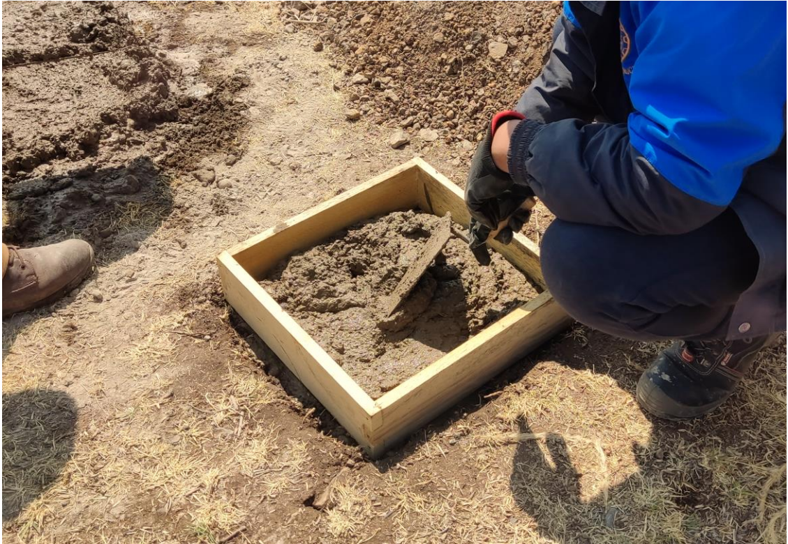
Nota: La fotografía representa la mezcla del concreto en los 10cm sobre el terreno para el punto PCG02. Elaboración propia.
