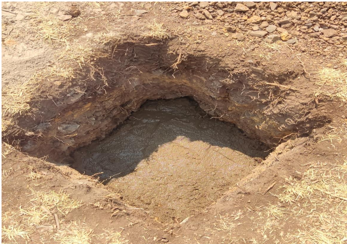
Nota: La fotografía representa la mezcla del concreto de la primera capa para el punto PCG02. Elaboración propia.
