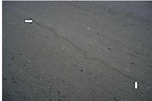
Nota: La imagen detalla las fisuras longitudinales y transversales. Tomado de: *Evaluación superficial de pavimentos asfálticos mediante las metodologías del MTC Perú y PCI* (p. 37), por M. Bravo, 2020, (<https://repositorio.urp.edu.pe>)
