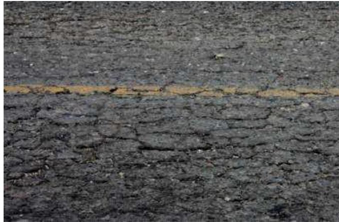
Nota: La imagen muestra el tipo de falla piel de cocodrilo. Tomado de: *Evaluación Superficial del Pavimento Flexible del Paseo Turicarami, Sullana - Piura utilizando Tecnología VANT* (p. 07), por F. Álvarez, R. Ramos, 2021, (<https://repositorio.ucv.edu.pe>).
