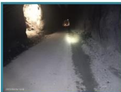
Imagen 11: En el nivel 4165 se tiene la vía inclinada hacia el hastial
