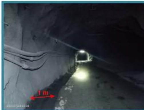
Imagen 03,04,05 y 06: Evidencias de cunetas fuera de estándar junto con las medidas tomadas IN SITU donde se evidencia un ancho mayor a los 80 centímetros
