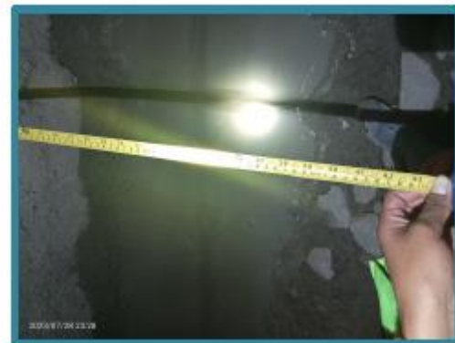
Imagen 03,04,05 y 06: Evidencias de cunetas fuera de estándar junto con las medidas tomadas IN SITU donde se evidencia un ancho mayor a los 80 centímetros
