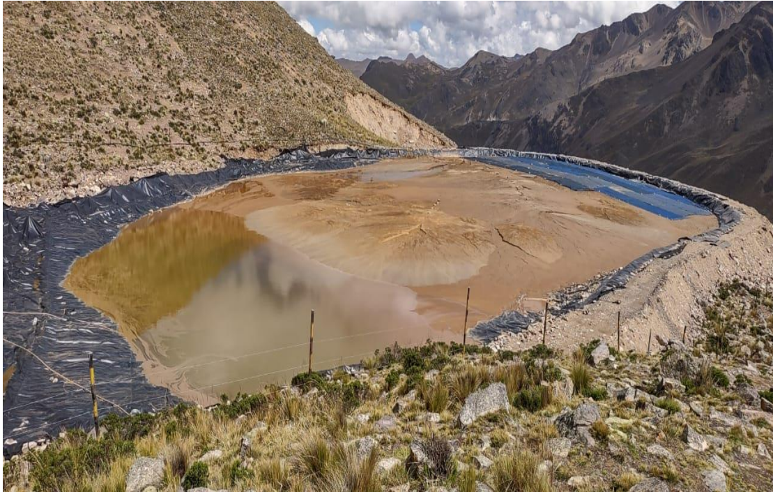
Cancha relavera es el depósito final de relaves
