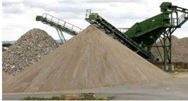
Figura 7. Reciclaje de tierras y escombros
