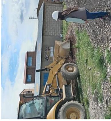
**FOTOGRAFIAS 01**, se muestra realización de calicatas a cielo abierto utilizando maquinaria donde de muestrearon
