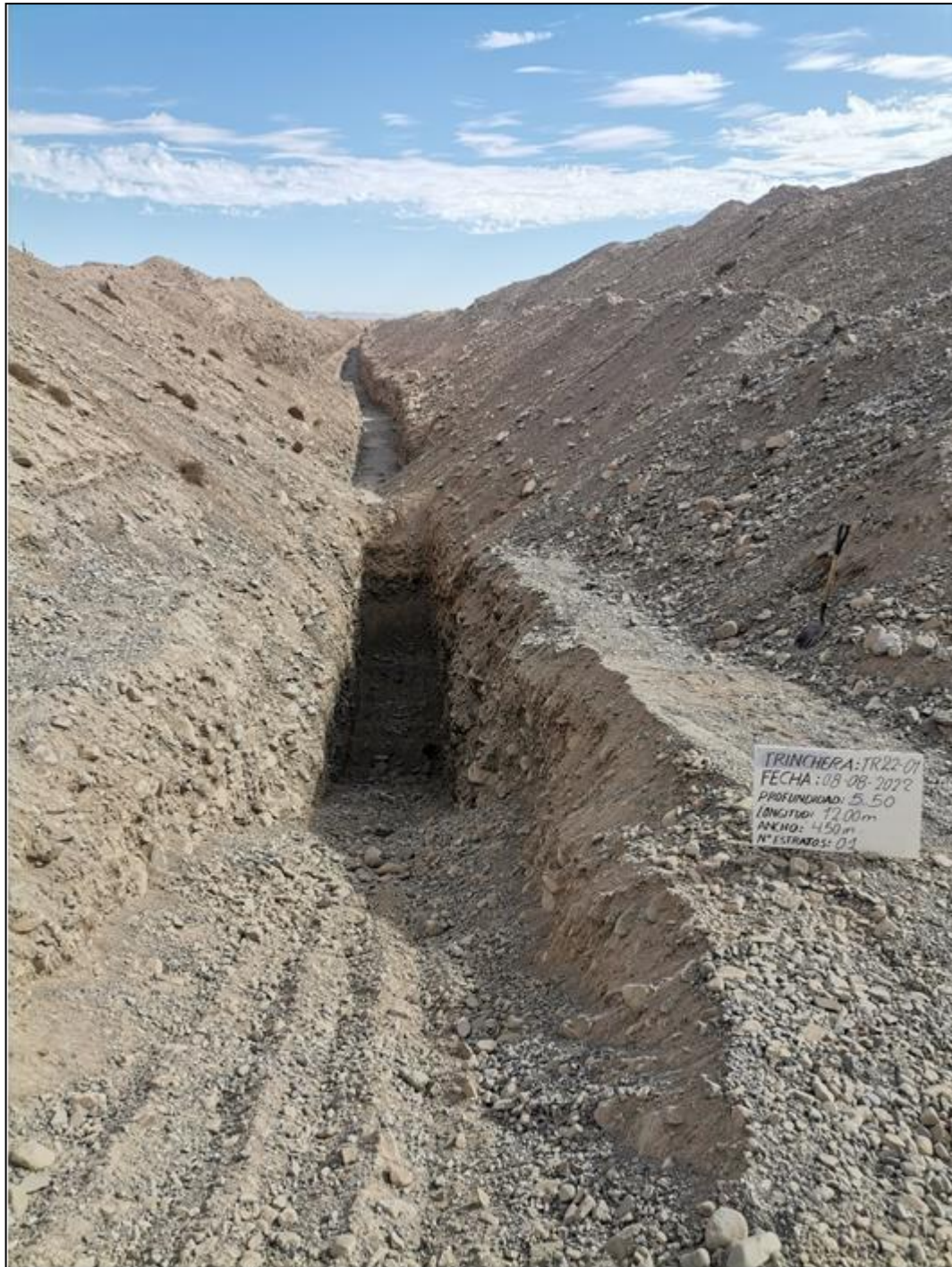
Nota: Fotografía de la primera trinchera realizada.
