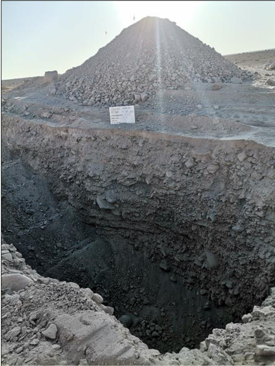
Nota: Fotografía de la calicata realizada.
