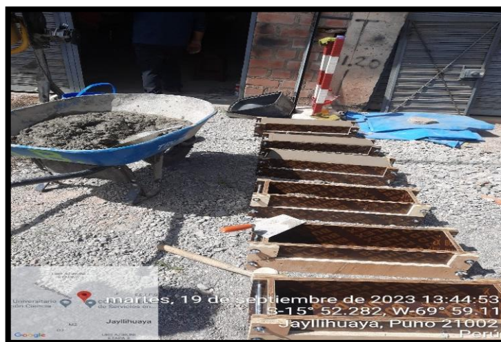
Fotografía 16. Se observa la elaboración de las viguetas primaticas.
