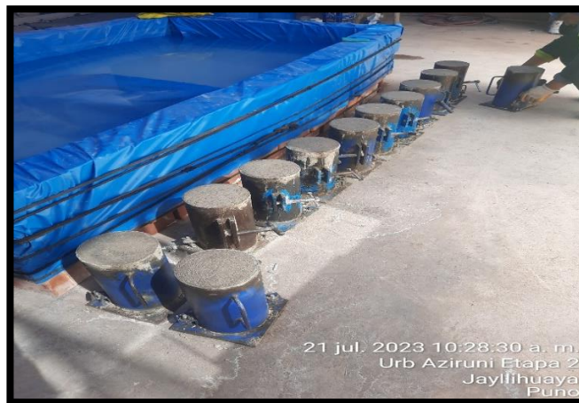
Fotografía 12. Se observa el concreto en los moldes de las briquetas.
