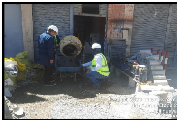
Fotografía 10. Se muestra la mezcla de concreto con cemento portland IP con 25% de puzolánico.
