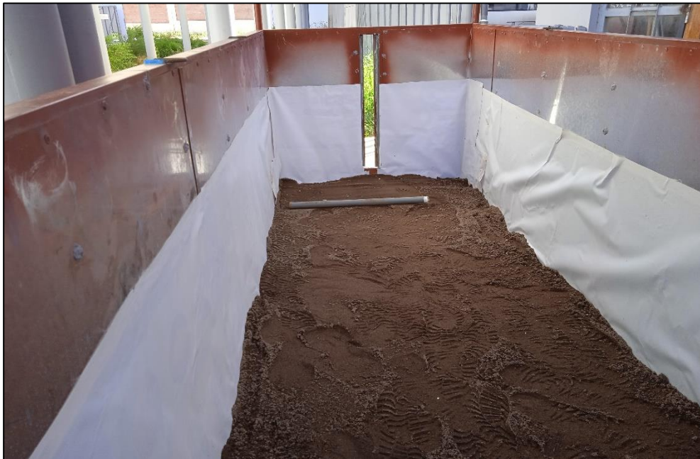
Colocación de las capas de arena en el contenedor
