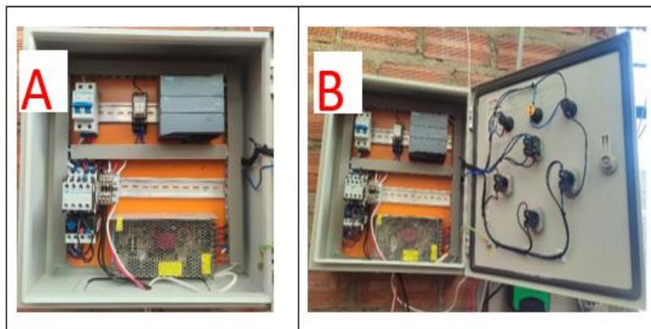
Nota: A: PLC. En funcionamiento, B: PLC. Recolección de datos.
