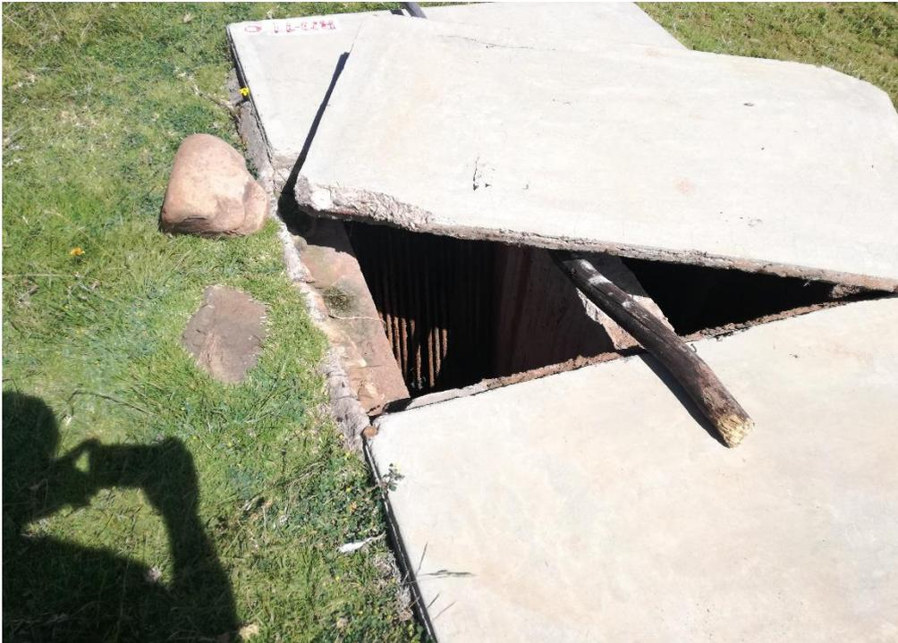
*Nota:* Se visualiza que la cámara de rejas tiene tapa de concreto.
