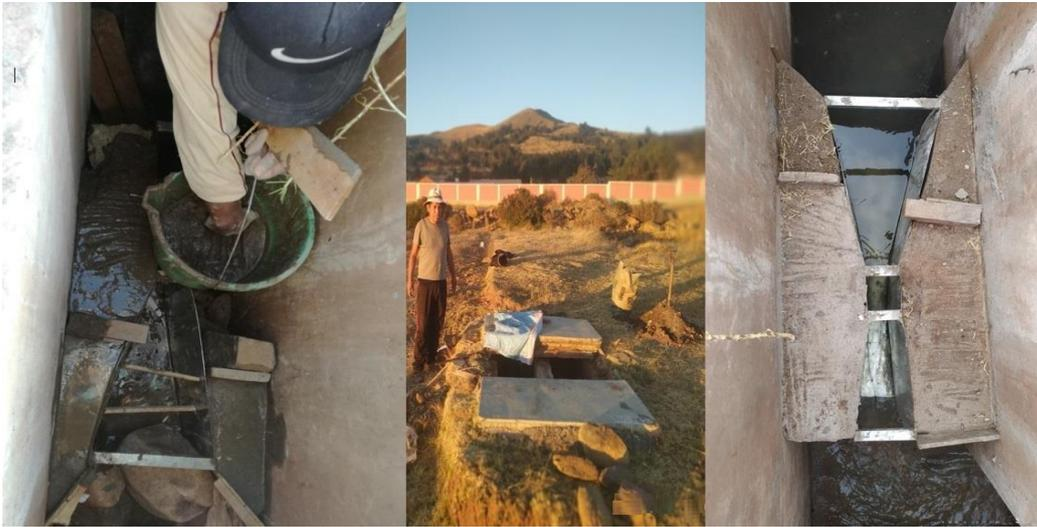
*Nota.* Se muestra la preparación de la mezcla de concreto (hormigón + cemento + agua), el vaciado de concreto conjuntamente con el medidor y la puesta en operación del agua residual.
