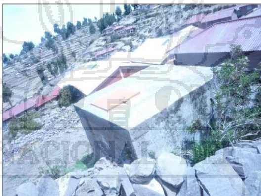
IMAGEN 36: Abastecimiento de agua y desagüe - Pozo de agua.
