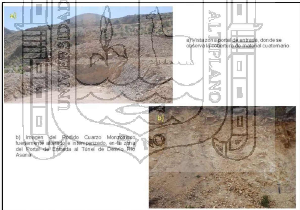
Figura N° 25, Fotografías del Portal de Entrada al Túnel de Desvío río Asana y Pórfido Cuarzo Monzonítico.
