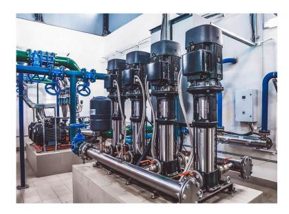
Nota: Fotografía de bombas centrífugas verticales de mpultiples escalonamientos (https://www.sintechpumps.com/bombas/que-son-las-bombas-de-turbina-vertical-y-comofuncionan/?lang=es).
