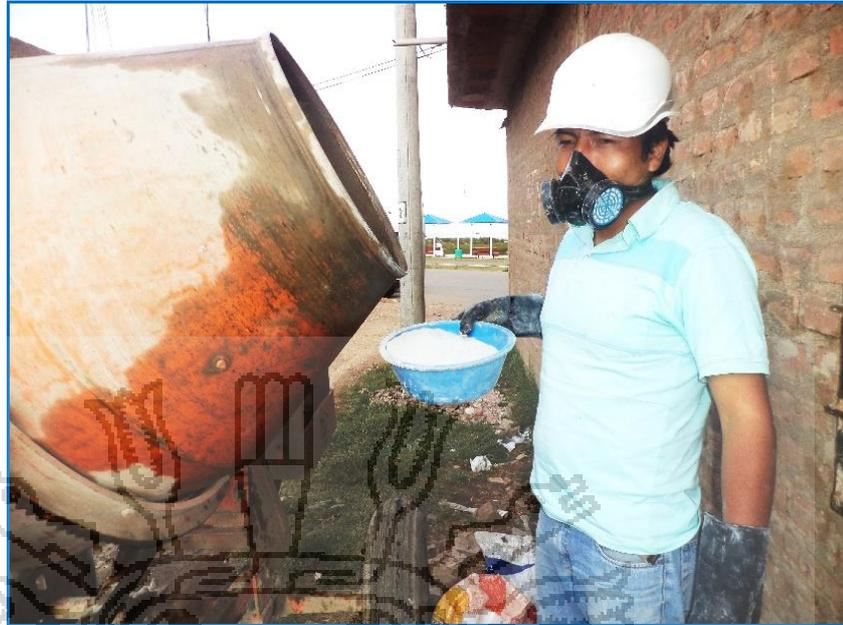
FIGURA 3.24: ADICIÓN DE MICROSÍLICE CON EQUIPO DE PROTECCIÓN ADECUADO.
