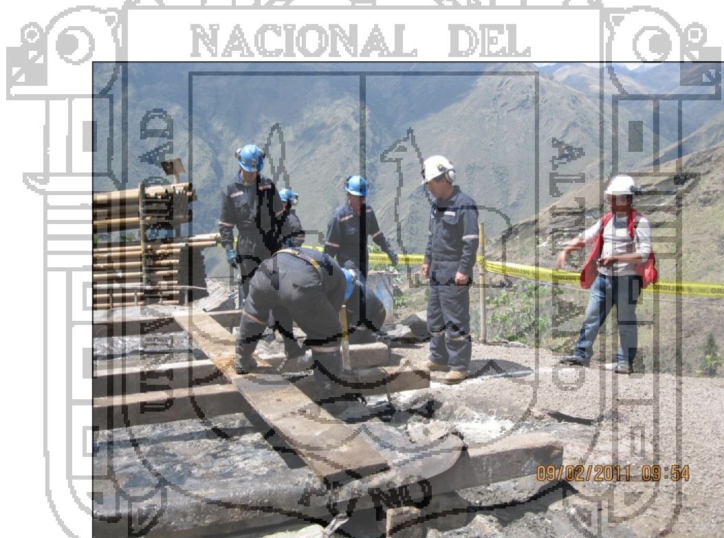
Foto N° 06: Supervisión de trabajos de ubicación de máquina de perforación, sobre plataforma de perforación.
