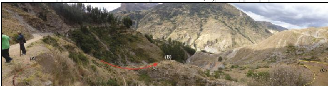
FOTOGRAFÍA 24 FORMACIÓN DE LOMERÍOS (B), ESCARPAS SECUNDARIAS (C) Y AGRIETAMIENTOS (A)
