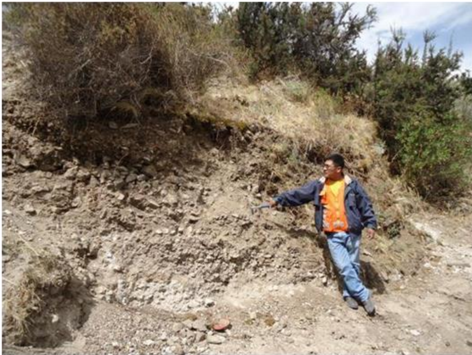
FOTOGRAFIA N° 4. Vista del Estribo izquierdo, obsérvese el material Coluvial conformado por gravas, bolones con matriz arenosa, limosa y arcillosa.
