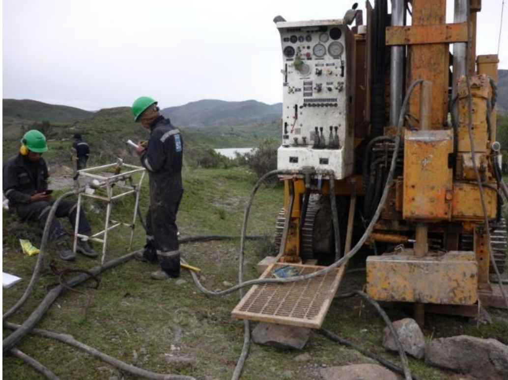
FOTOGRAFIA N° 8. Sondaje PPA-05, Realización de ensayo de permeabilidad tipo Lefranc.
