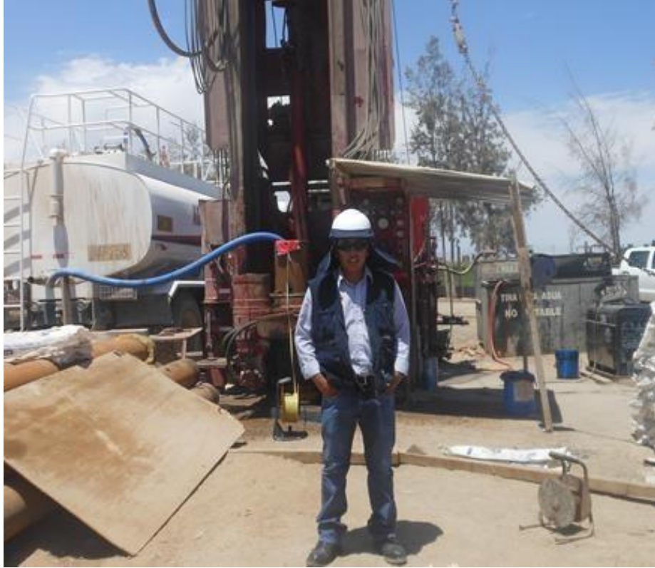
FOTOGRAFIA N° 1. Pruebas de infiltracion
