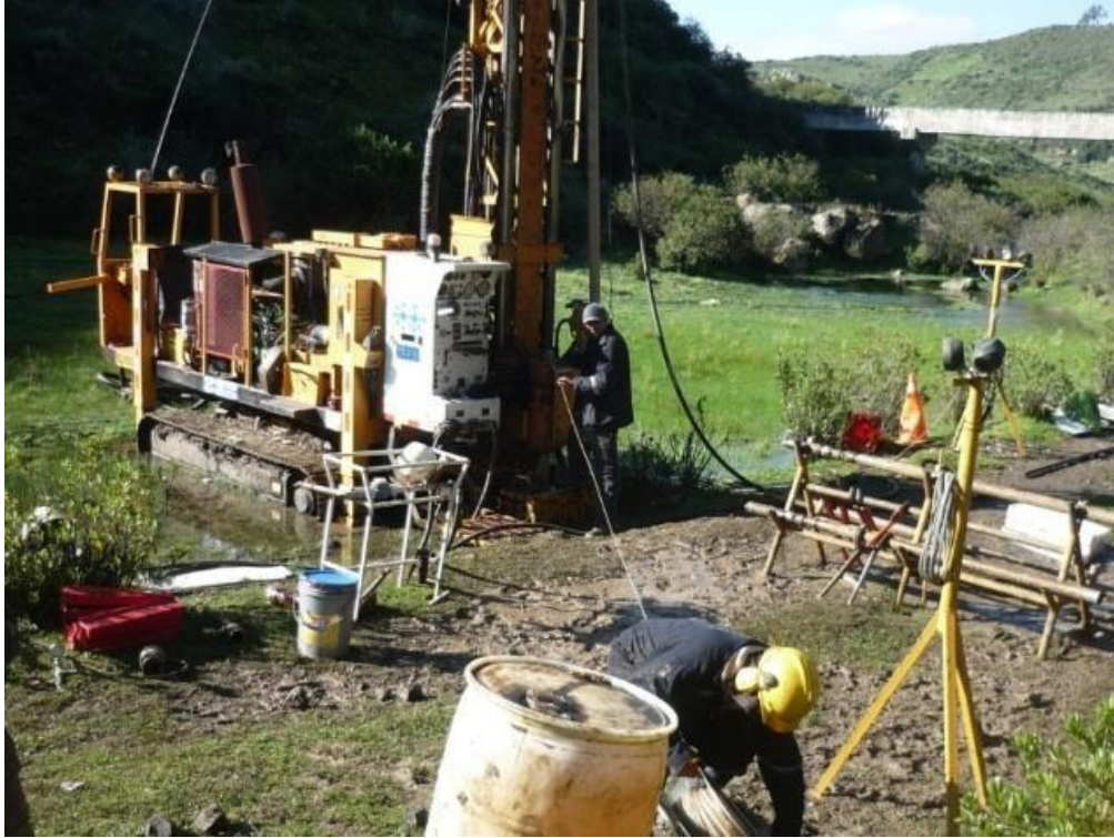
FOTOGRAFIA N° 6. Zona de trabajo, sondaje PPA-01, Estribo izquierdo Con máquina UDR-710, preparando para hacer ensayo Lefranc.
