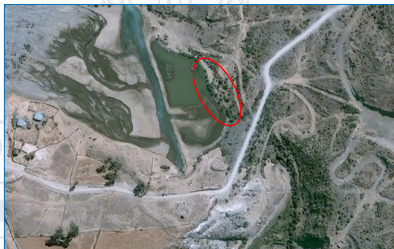
FIGURA N° 13: ZONA DE TRATAMIENTO GEOTECNICO
