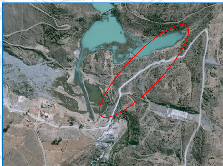
FIGURA N° 15: TRATAMIENTO GEOTÉCNICO DE LA ZONA 5
