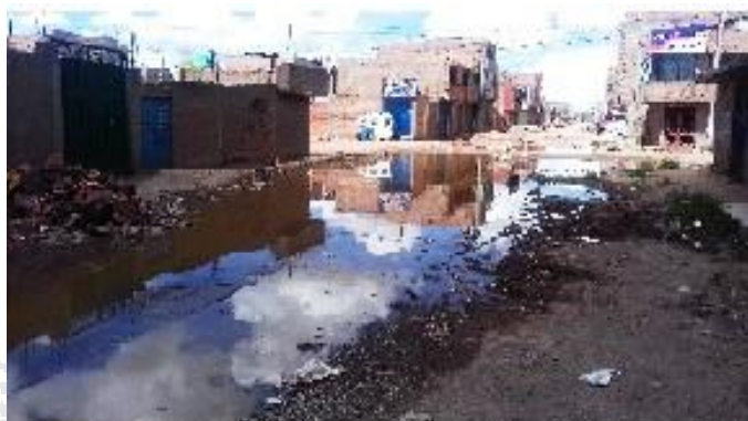
Figura 13: Aniegos en las calles a falta de mantenimiento
