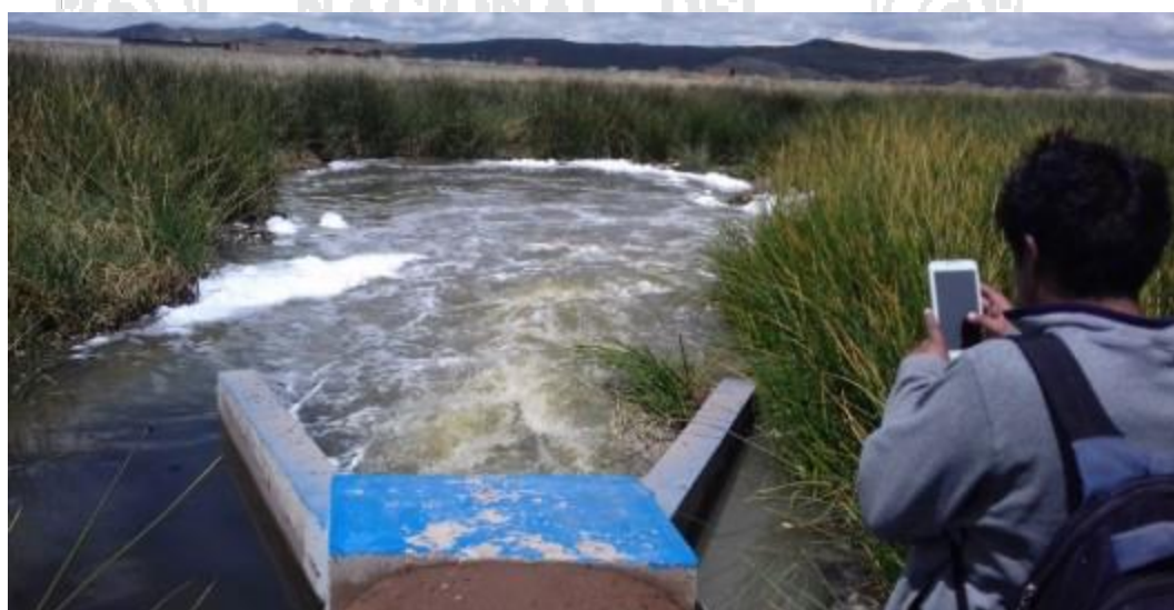
Figura 11: Desembocadura de aguas tratadas de SEDA Juliaca
