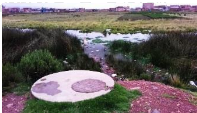
Figura 18: Instalación de redes de alcantarillado en las riberas del río Torococha
