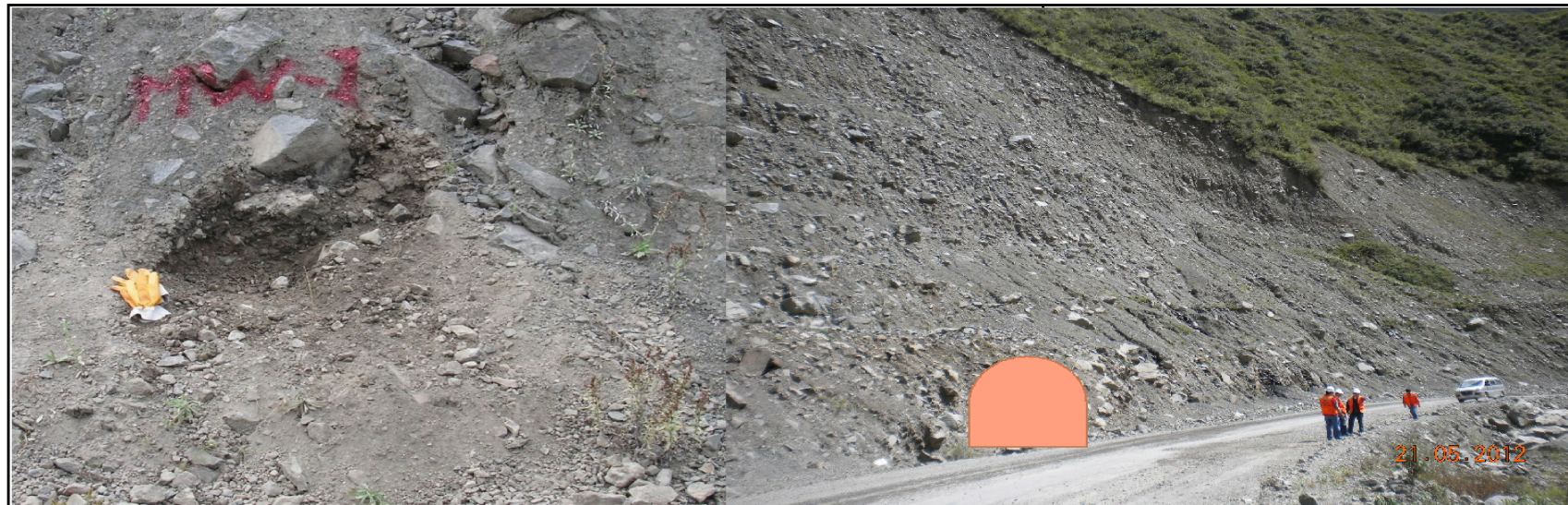
FOTOGRAFÍAS DE AFLORAMIENTO - ESTACIÓN GEOTÉCNICA
