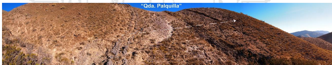
Figura 48: Vista al noreste de la sección “Quebrada Palquilla”. La flecha entrecortada indica la dirección de la sección estratigráfica levantada.
