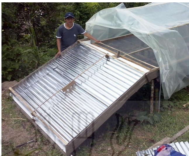
Fig. 16. Instalación del colector solar
