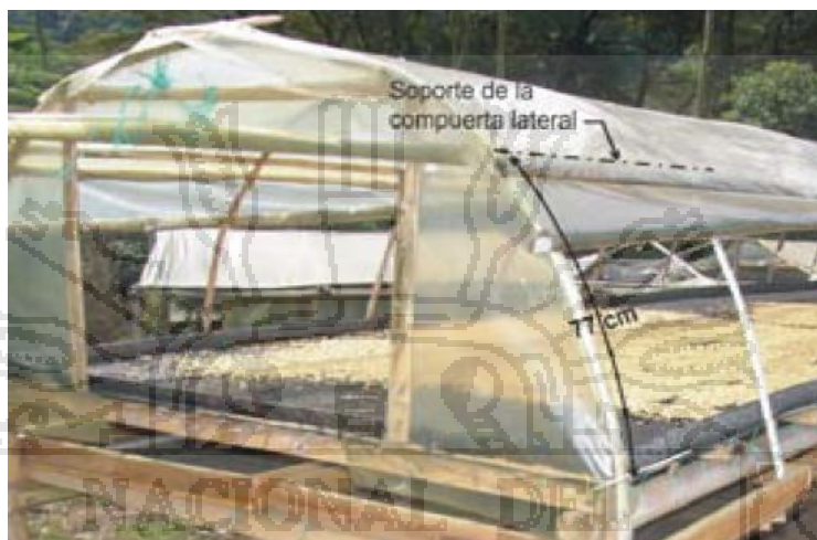
Fig. 14. Distancia sobre los arcos para fijar las compuertas laterales
