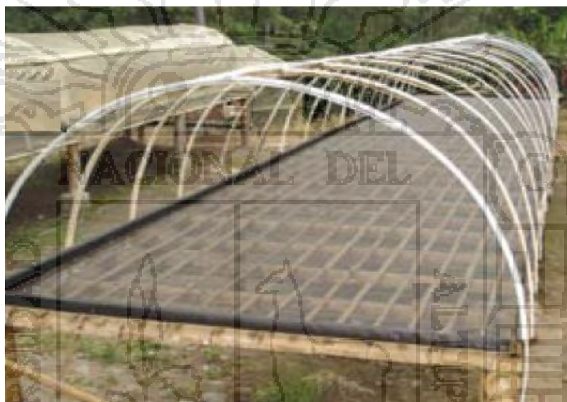
Fig. 13. Arcos que forman la estructura para soportar la cubierta plástica.
