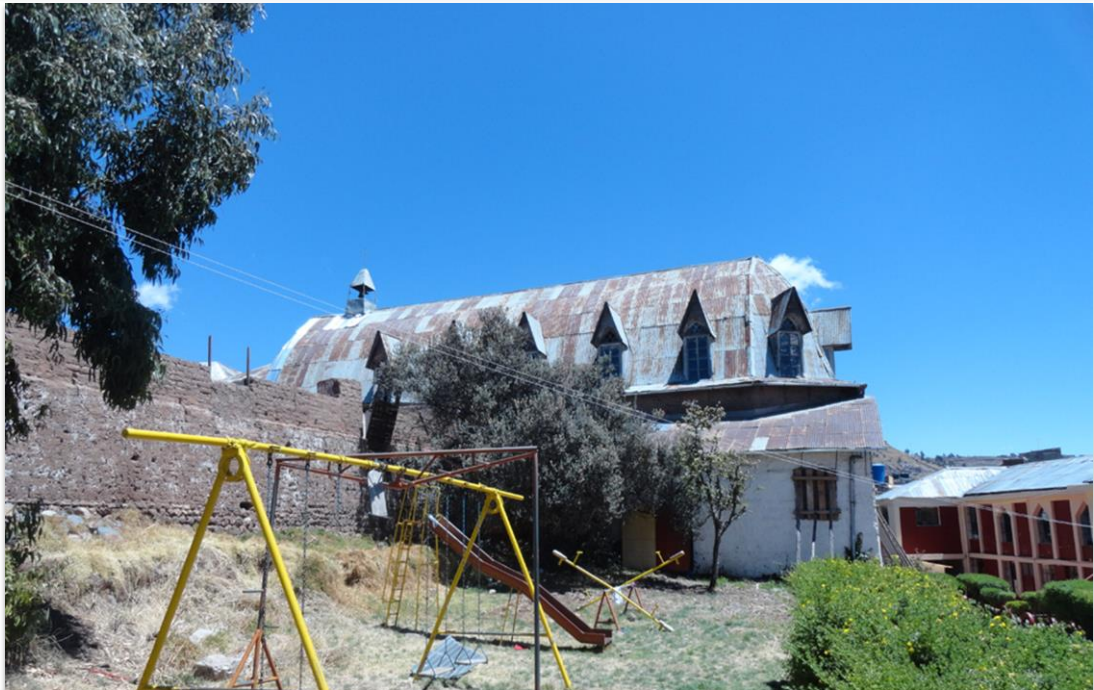
FOTO N° 17 PRESENCIA DE VEGETACION EN LOS EXTERIORES
