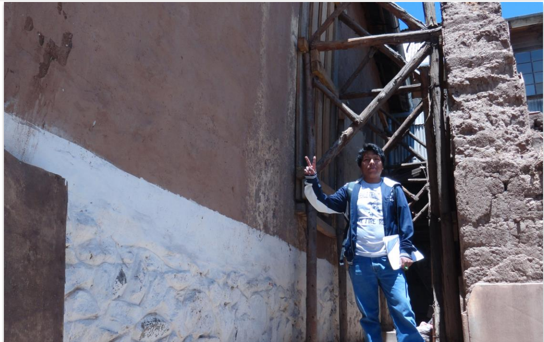
FOTO N° 01 RELEVAMIENTO DE LOS MUROS EXTERIORES
