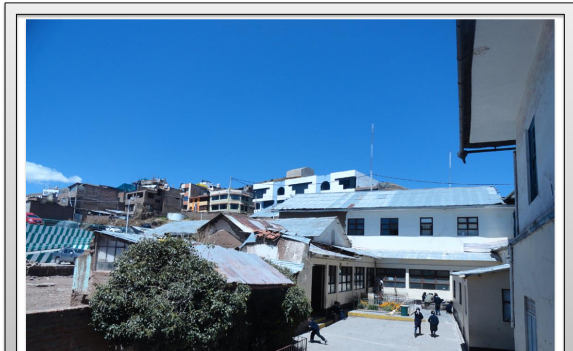
FOTO N° 12 VISTA PERPENDICULAR A LA FACHADA DE LA CAPILLA
