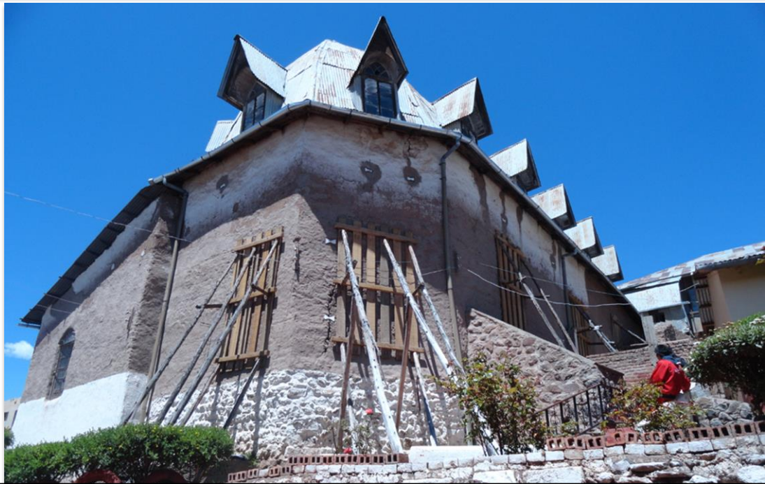
FOTO N° 15 MUROS POSTERIOR Y LATERAL APUNTALADOS
