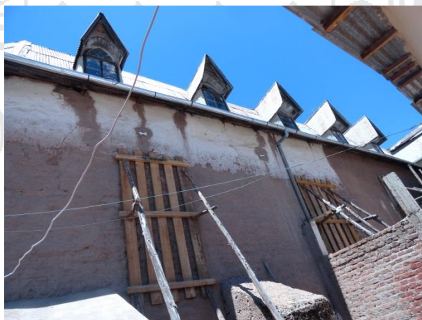
Ilustración 22. Fachada de la Epístola
