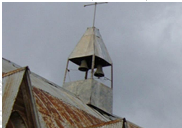
Ilustración 37. Campanario de la Capilla
