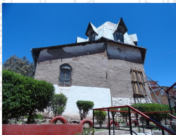
Ilustración 21. Fachada Posterior de la Capilla
