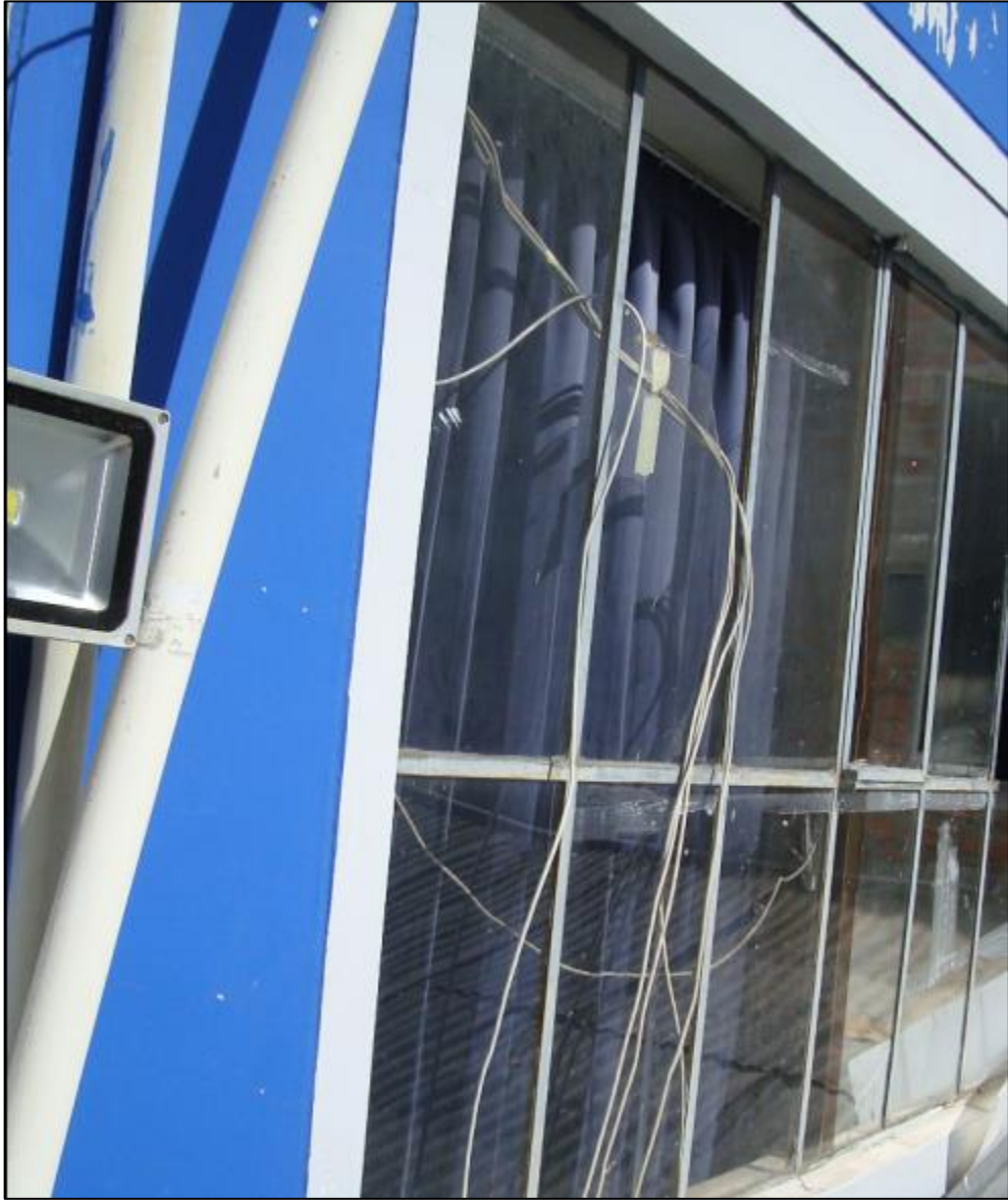
Ventana con vidrio facturado – Data Center – Tercer Piso Edificio A
