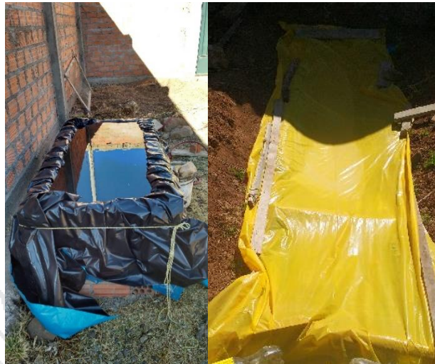
Figura 3. 15 Elaboración de pozas de curado para especímenes de prueba
