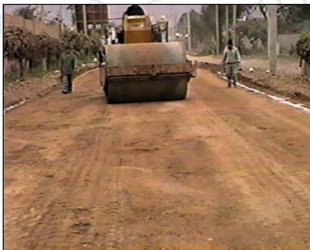
*Figura 6: Compactación de la superficie de rodadura estabilizada.*
