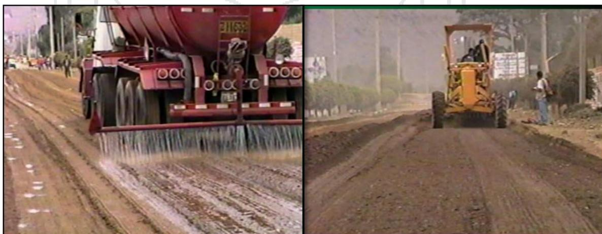
*Figura 2:* Mezclado del aditivo Perma Zyme con el suelo.
