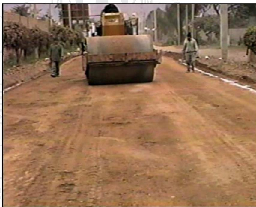
*Figura 3: Compactación de la superficie de rodadura estabilizada.*
