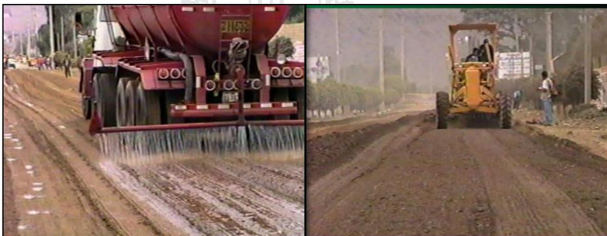
*Figura 5: Mezclado del aditivo Cloruro de Calcio con el suelo.*
