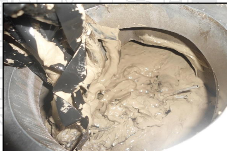
Figura 30. La succión de la bomba está bloqueada con viruta y lodo.
