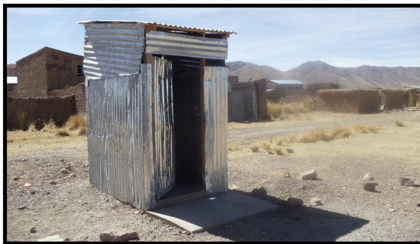
Figura N° 57: Letrina con Cobertura y Muros de Calamina Agua – Sector Malliripata (Visita a Campo)
