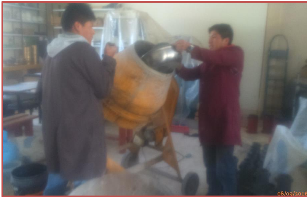
Figura 3.23 Mezclado del concreto.
