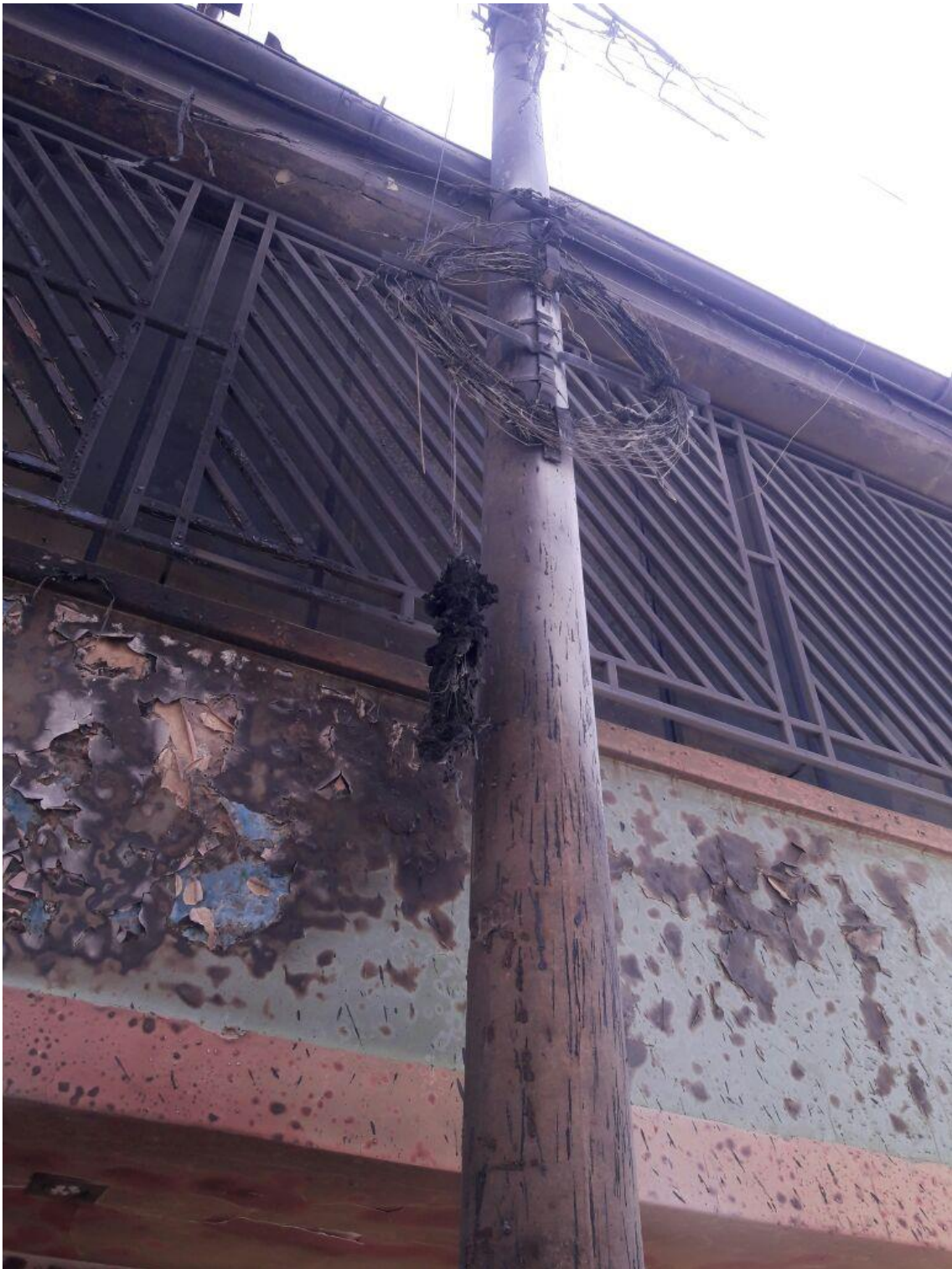
Anexo 3: Mufa de Fiber Lux quemada
