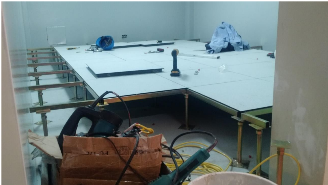
Figura 4: Piso Elevado CPD de respaldo Juliaca. Fuente: CPD Juliaca
