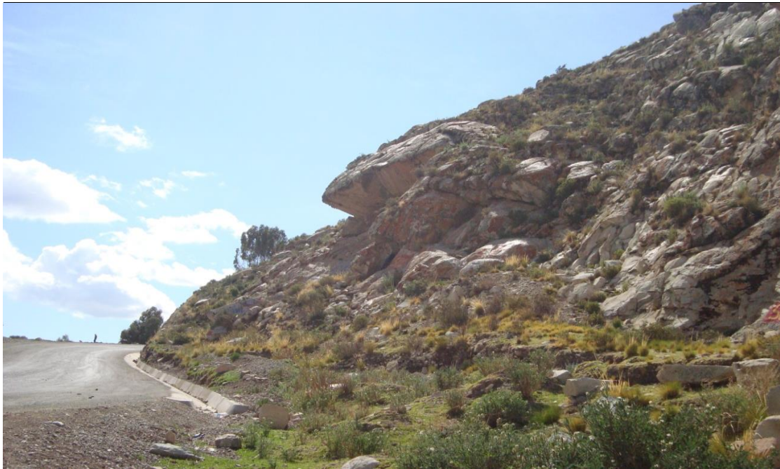
Foto N° 07. Zona inestable en casos de Sismos. (Km. 1+980, Estación N° 1)
