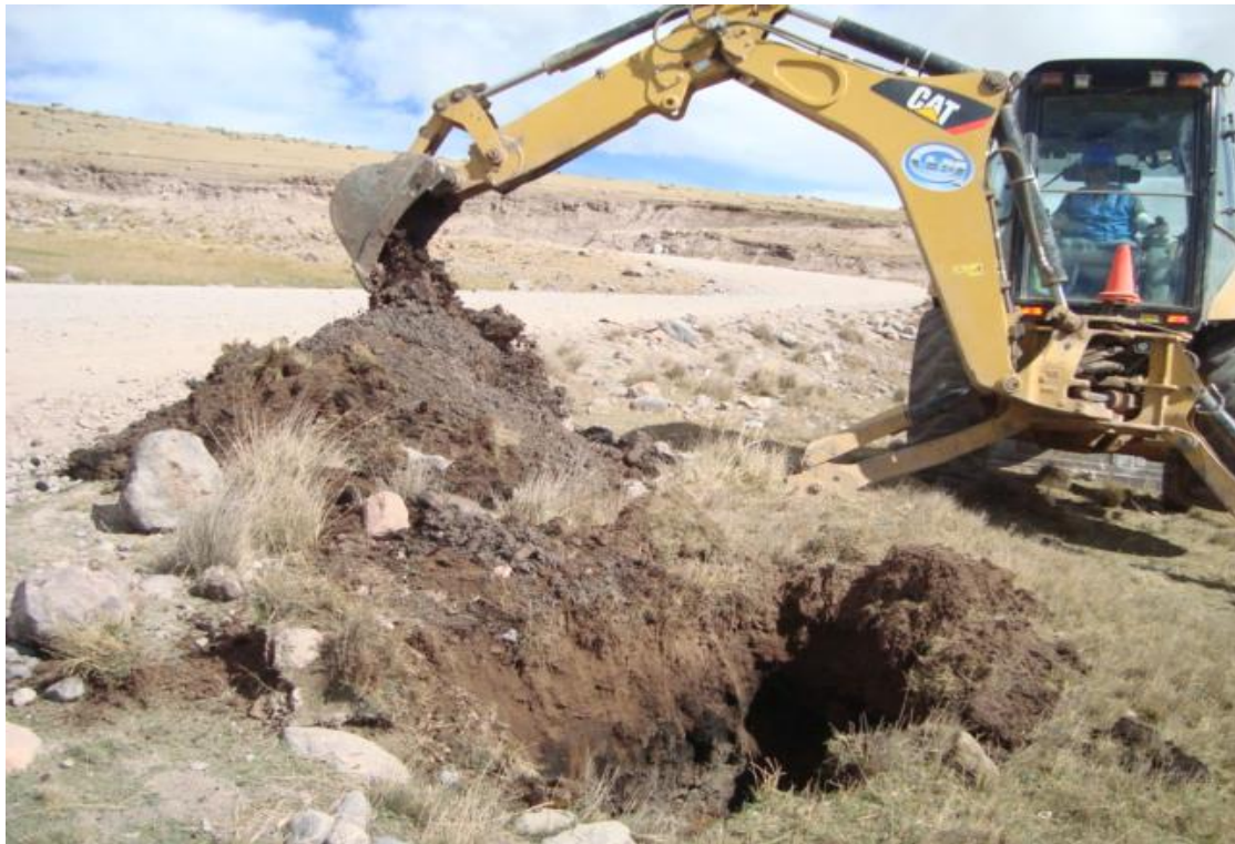
Foto N° 01. Excavación de Calicatas con apoyo de retroexcavadora. (Suelo de fundación)
