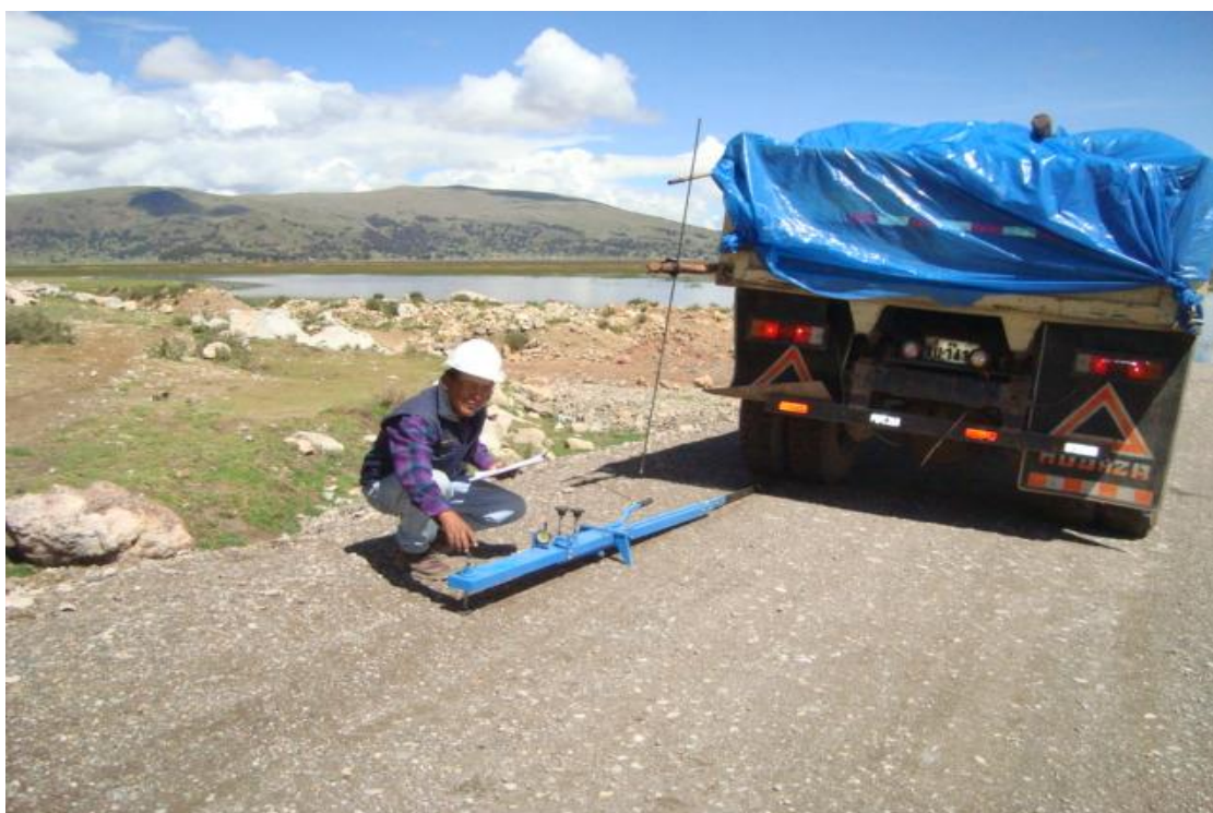
Foto N° 10. Técnica de colocación de equipo de Viga Benkelman en el punto de prueba de la carretera en construcción. (Base granular)
