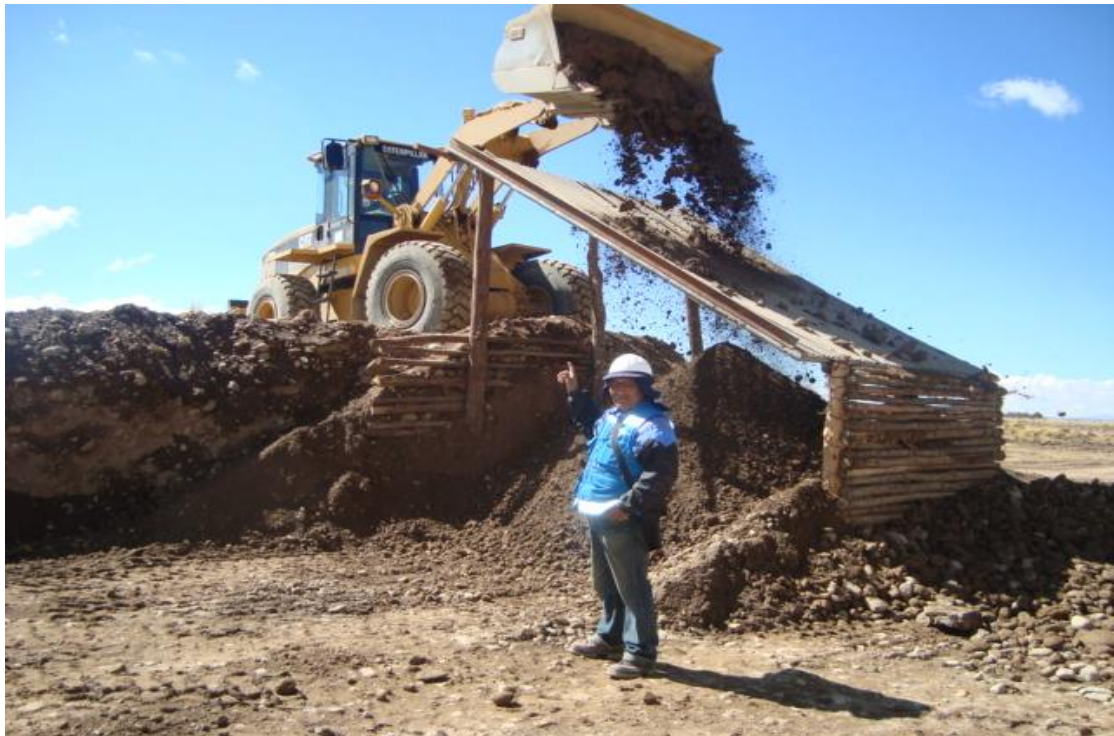
Foto N° 03. Explotación de cantera Quipata. (Zarandeo del material Sub-rasante)
