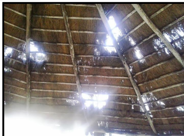
IMAGEN N° 59 ESTADO ACTUAL DE CUBIERTAS
