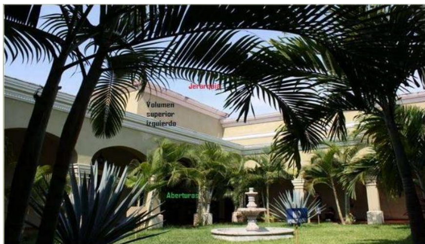
Imagen N° 5: edificio talleres limitantes del espacio.
