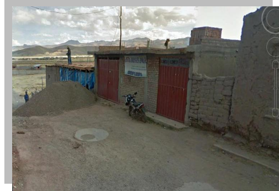
Imagen N° 61 : 1 Vivienda Constr. Material Noble.
