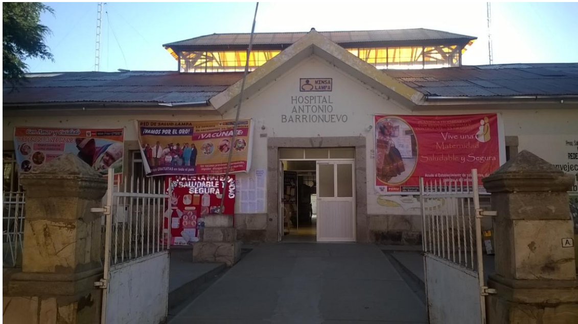
Foto N° 5 Hospital “Antonio Barrionuevo” Lampa 2016
