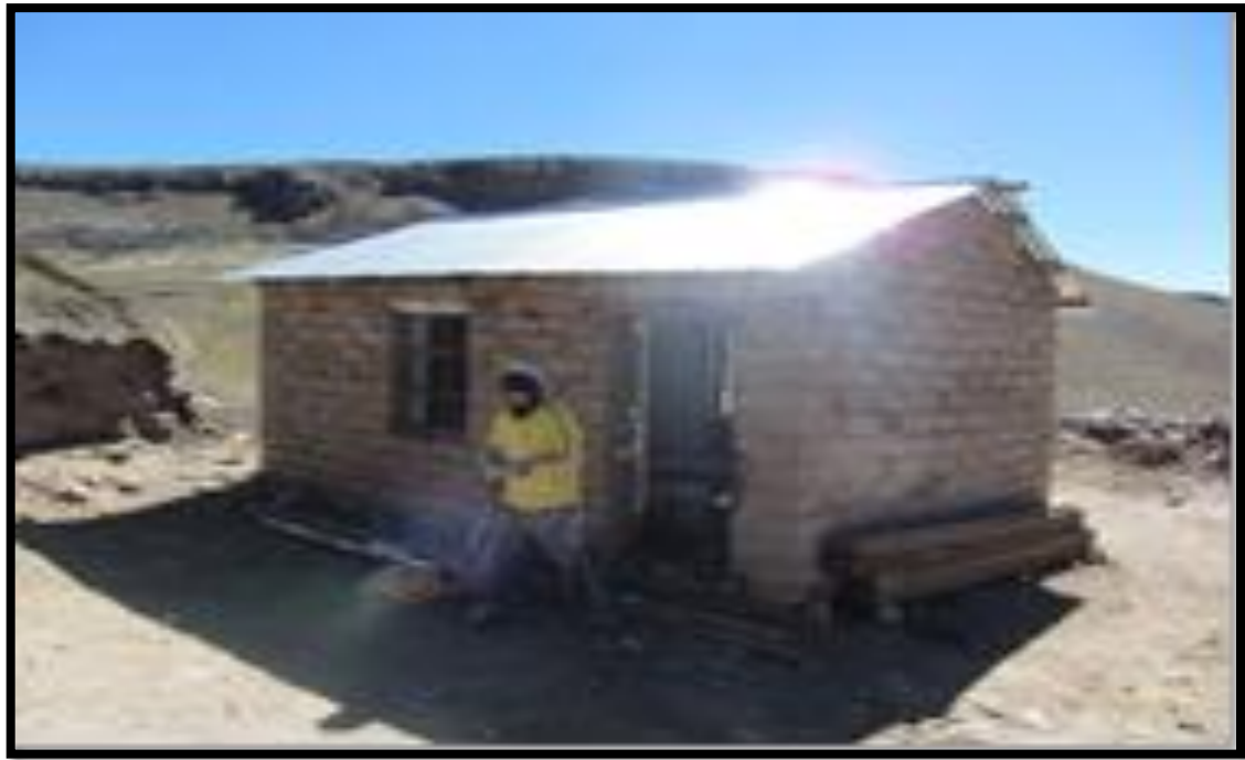
Construcción de Viviendas saludables en la comunidad de chivay.
