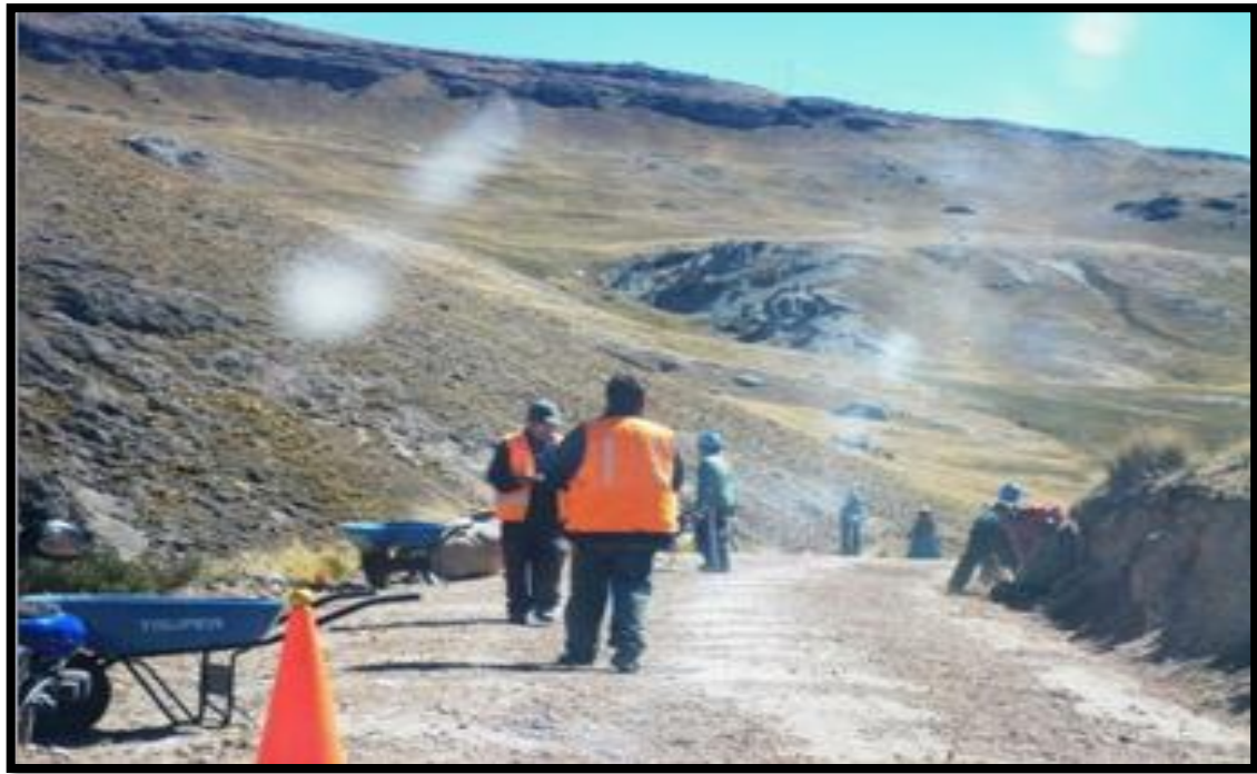
Mantenimiento de la carretera de distrito de Ocuviari a la Comunidad de Parina.
