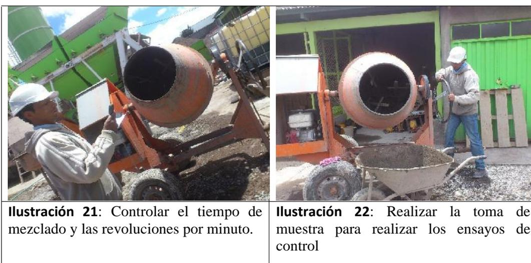
**Ilustración 21:** Controlar el tiempo de mezclado y las revoluciones por minuto.
