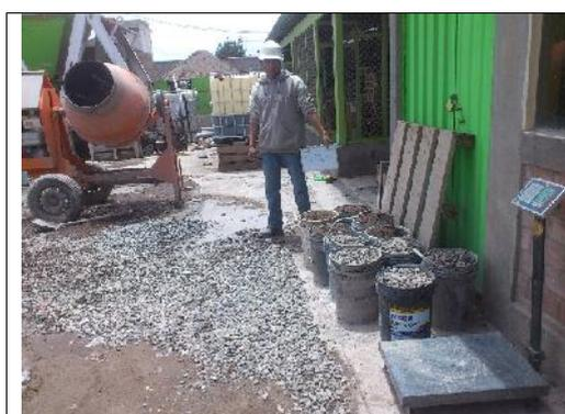
**Ilustración 19:** Pesar los materiales para realizar el diseño.
