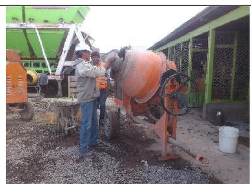
**Ilustración 20:** Verter los materiales a la mezcladora
