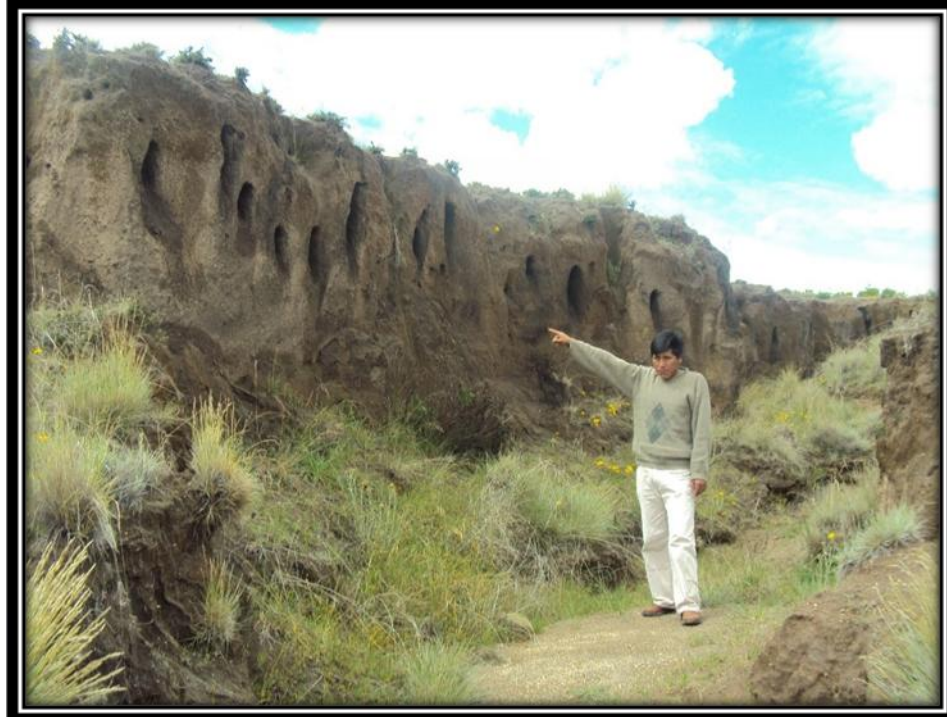
Fotografía N° 05. Talud en progresiva 0+180, de la cárcava.
