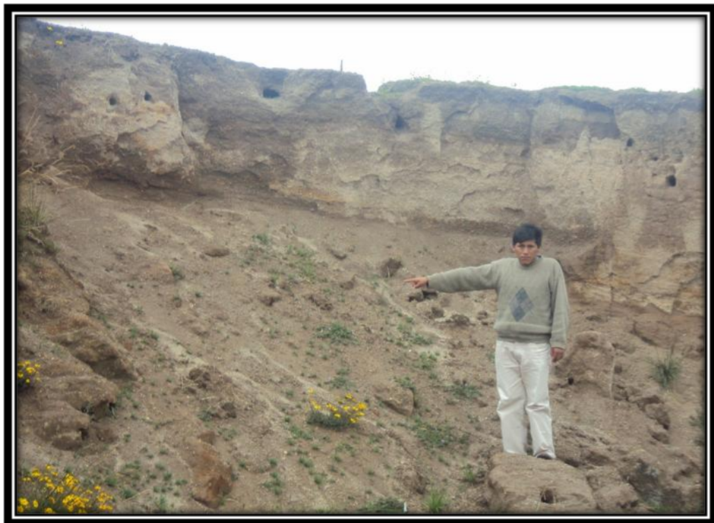
Fotografía N° 09. Movimiento de masa de suelo en talud lateral.
