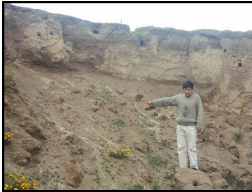
Figura 6: Movimiento en masa en el talud lateral de la cárcava
