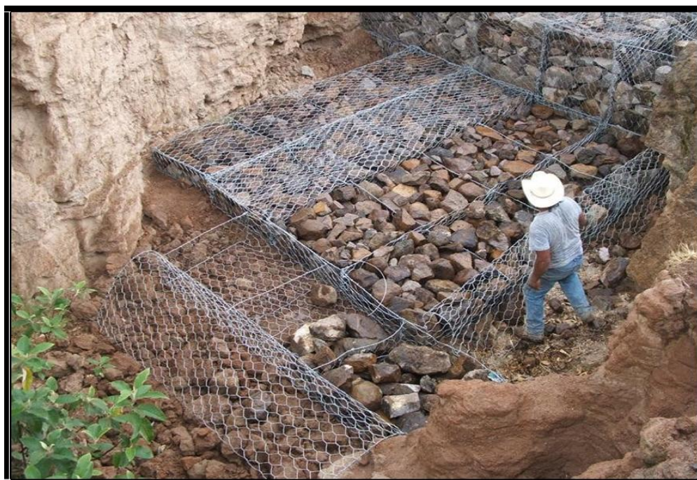
Figura 14: Colchonetas de gaviones
