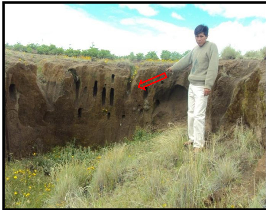
Figura 9: Avance en la cabeza de la cárcava.
