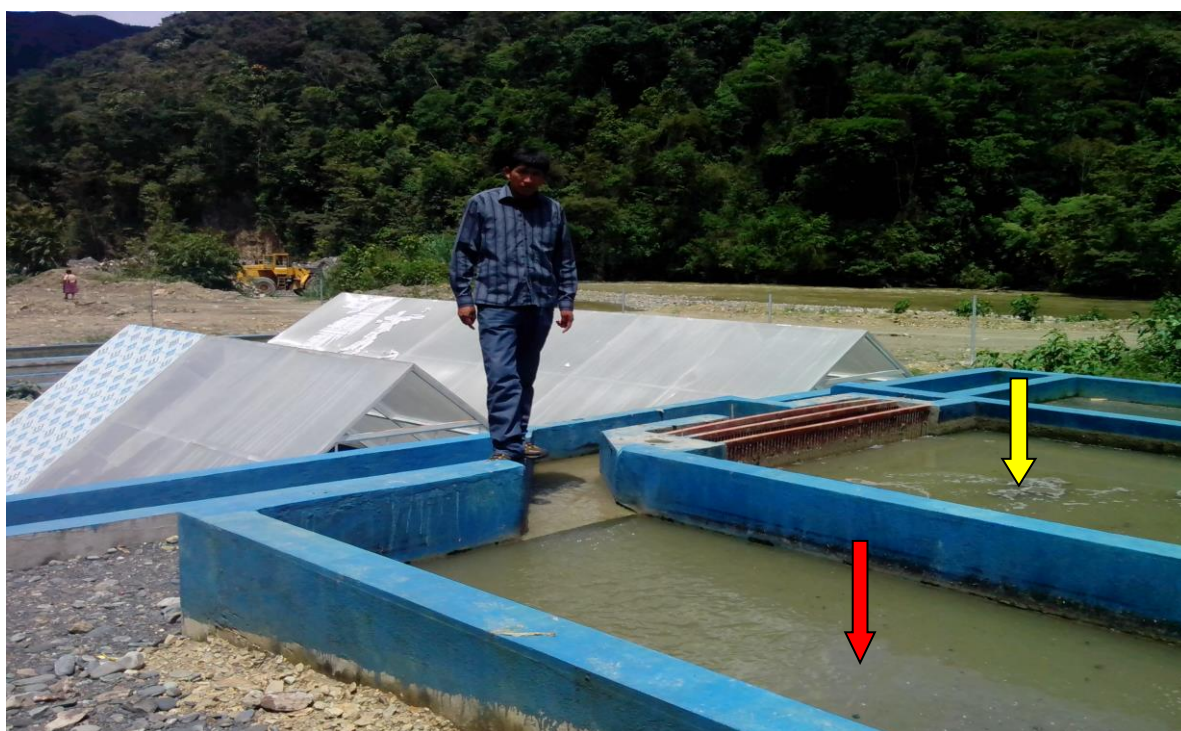
FIGURA N° 05. Se aprecia la flecha de color amarillo sedimentador primario y color rojo sedimentador secundario.
