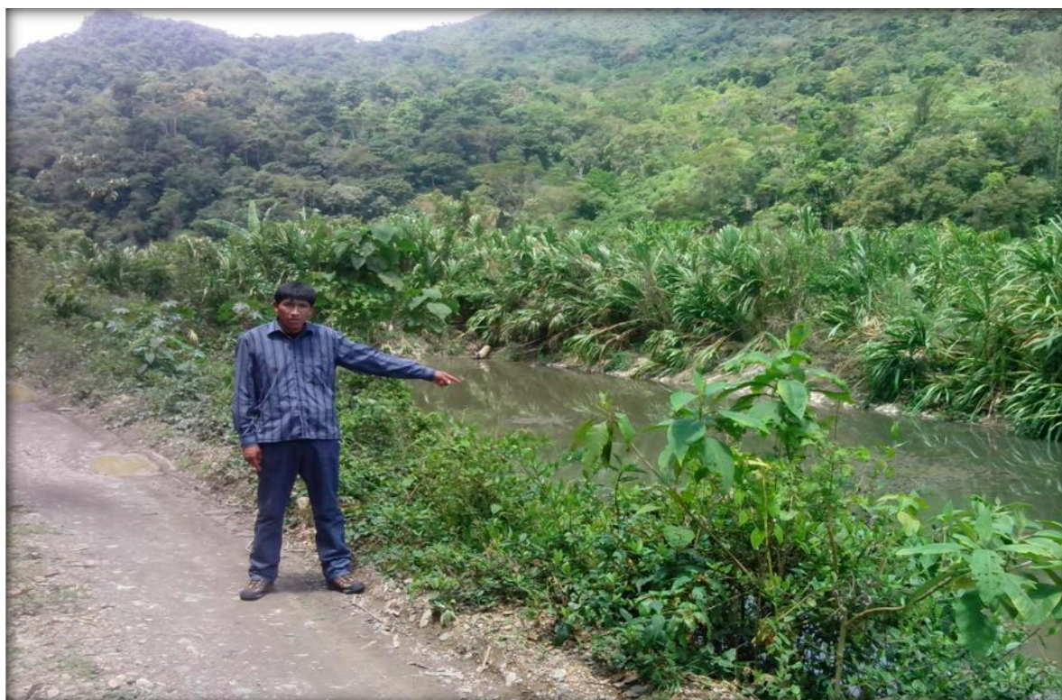
FIGURA N° 02. SE EVIDENCIA LA SITUACIÓN ACTUAL DE LA LAGUNA DE ESTABILIZACION
