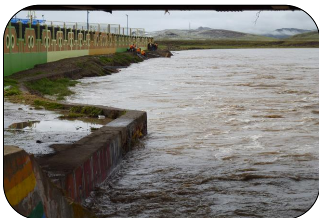
Imagen N° 07: Panorámico afectando el parque recreacional del barrio Ccahuasi Mashí en la margen izquierda del rio.
