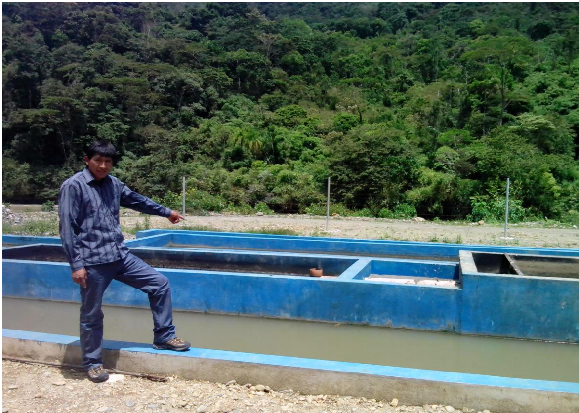
FIGURA N° 04. SE OBSERVA EL SEPARADOR DE SÓLIDOS Y DESENGRASADOR
